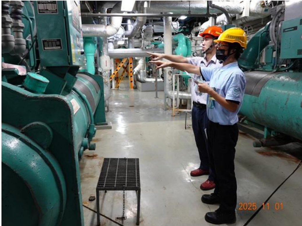
核安會視察員查核 1 號機聯合結構廠房現場狀況
