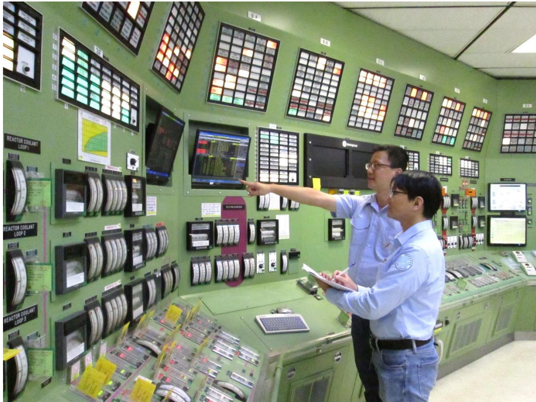
核安會視察員查核 1 號機主控制室機組狀況
