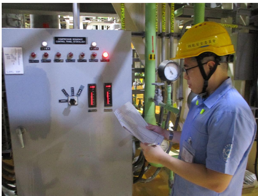
核安會視察員查核 1 號機汽機廠房現場狀況
