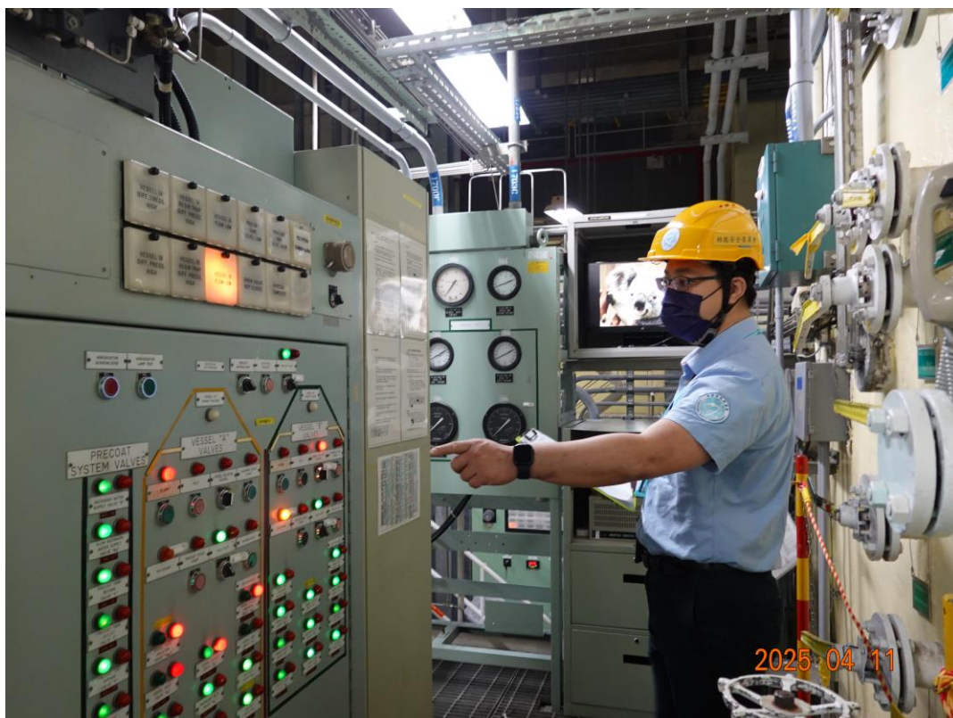
核安會視察員查核 1 號機反應器廠房現場狀況
