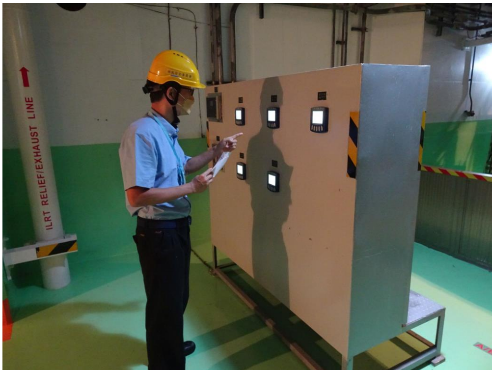
核安會視察員查核 1 號機輔機廠房設備狀況
