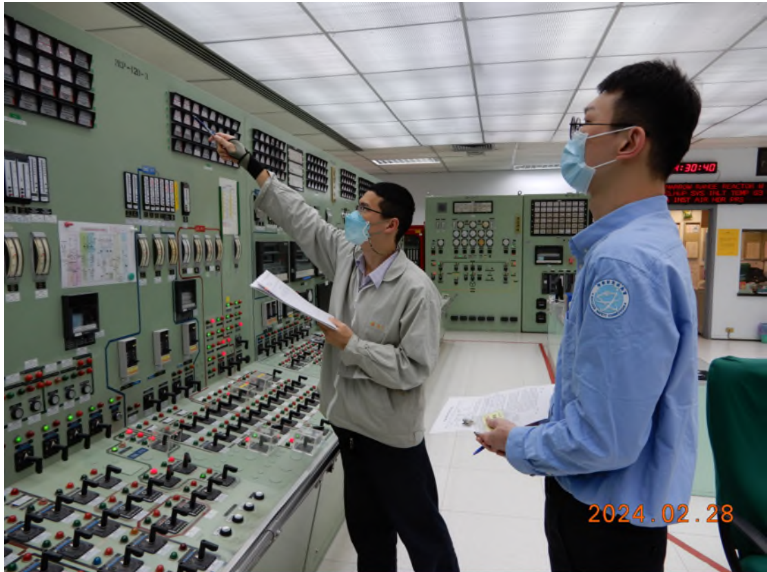
核安會視察員於 1 號機主控制室查核運轉值班人員機組掌握狀況
