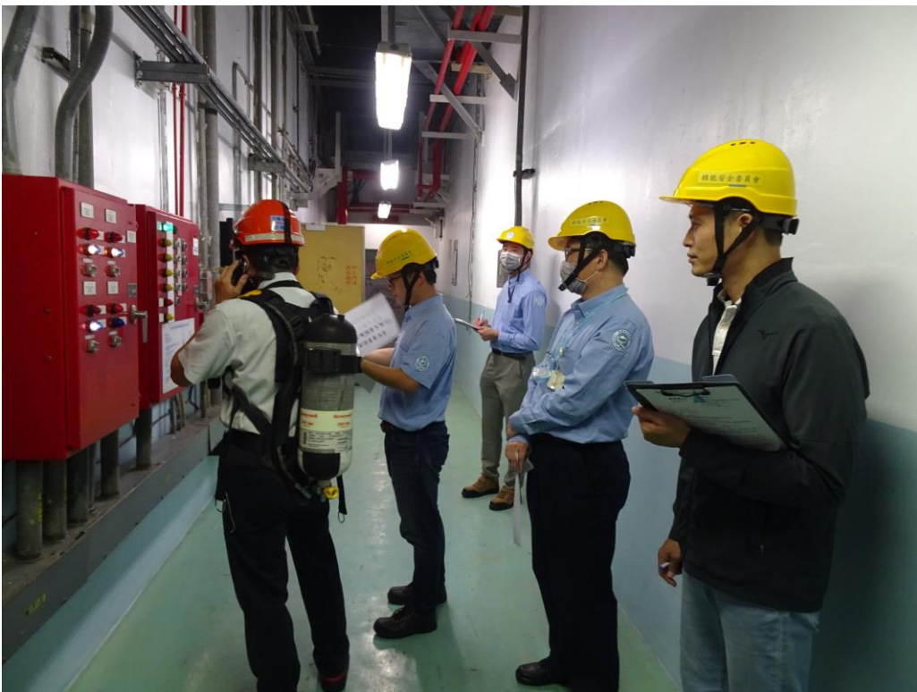
查核值班員執行消防手動開關操作之情形
