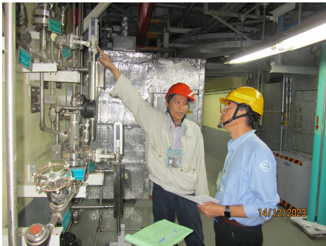
核安會視察員查核 2 號機反應器廠房現場設備狀況
