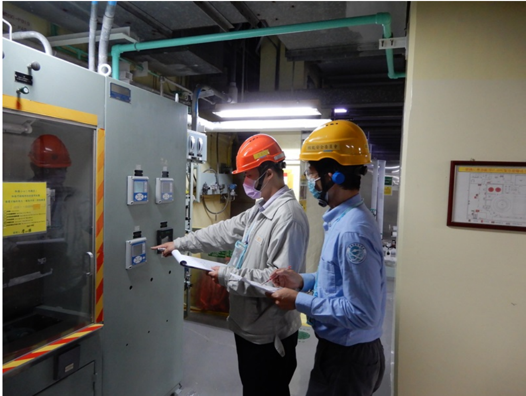
核安會視察員查核 1 號機反應器廠房設備狀況
