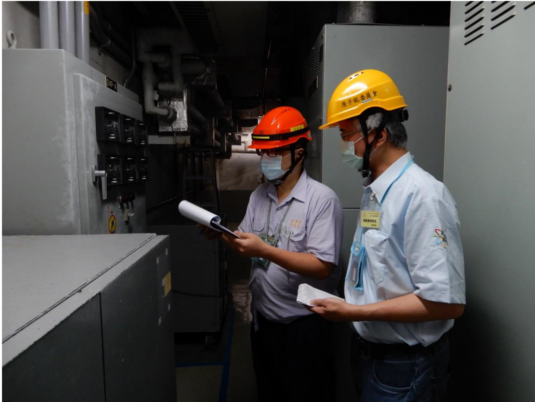
原能會視察員查核 1 號機反應器廠房現場狀況
