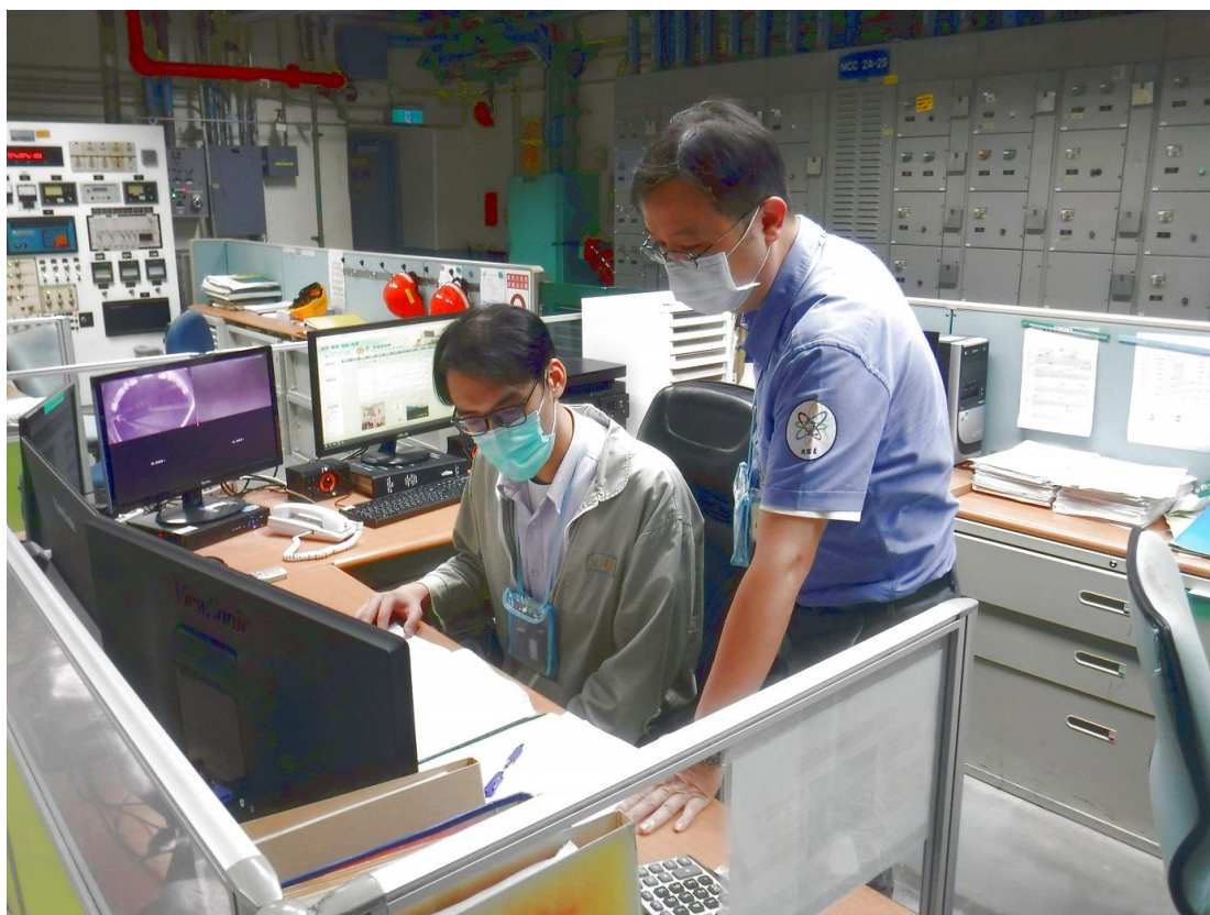
原能會視察員查核廢料廠房控制室運轉狀況
