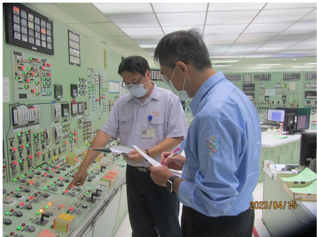
原能會視察員於 2 號機主控制室查核值班人員掌握機組狀況
