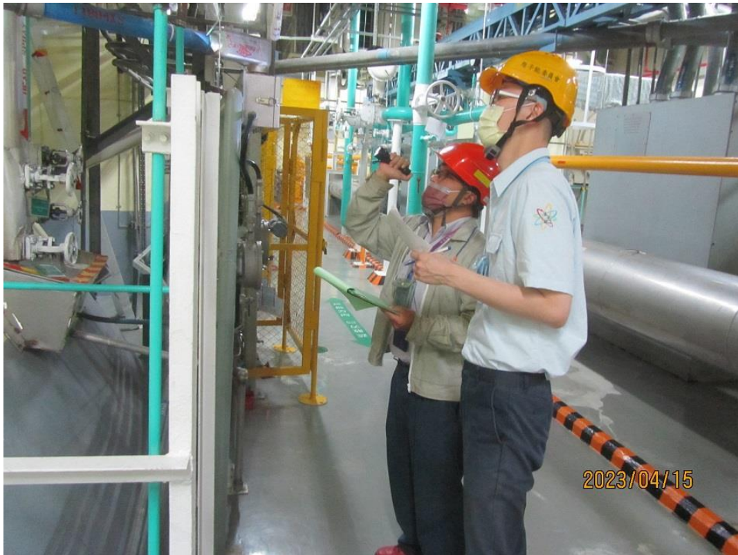
原能會視察員查核 2 號機反應器廠房現場狀況
