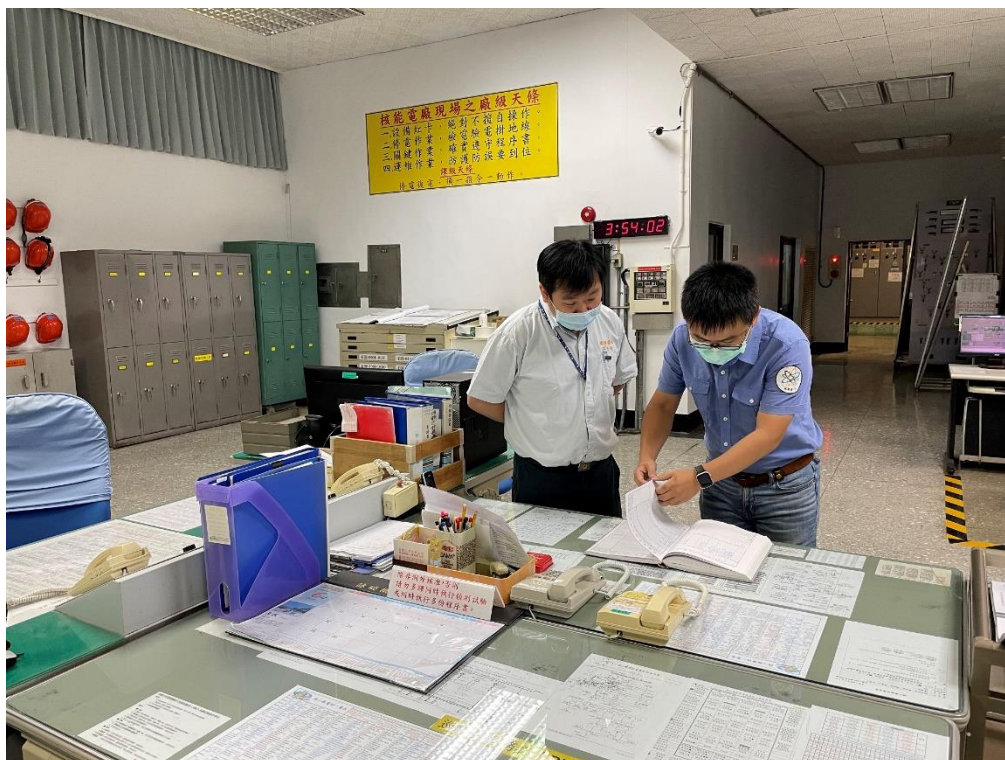
原能會視察員查核開關場控制室狀況
