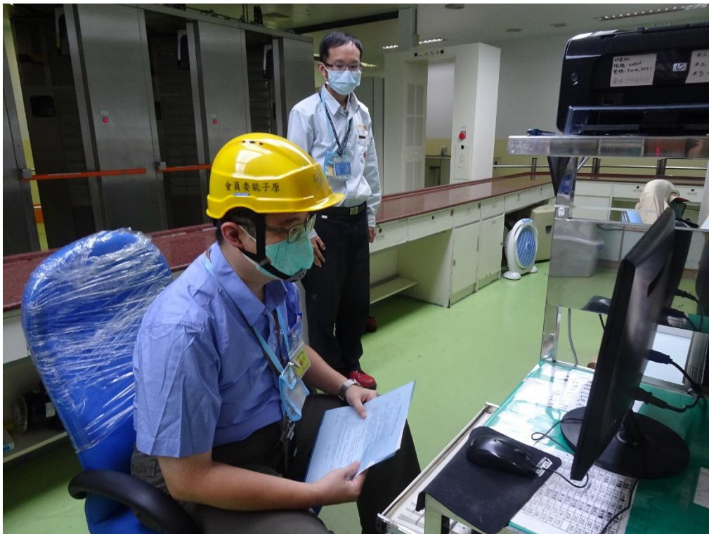
原能會視察員查核輻防管制站狀況
