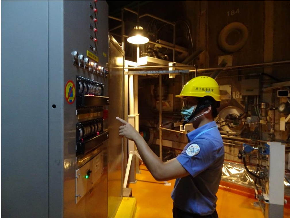
原能會視察員查核 2 號機輔機廠房現場狀況
