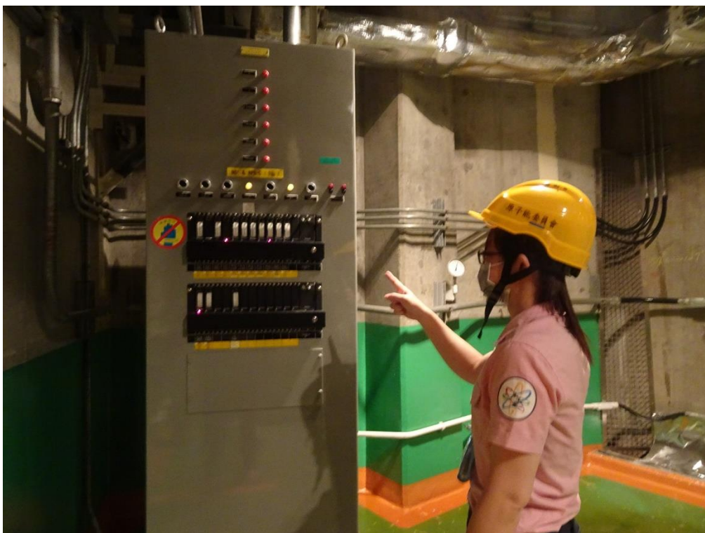
原能會視察員查核 1 號機輔機廠房現場狀況
