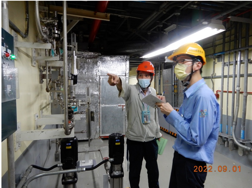
原能會視察員查核 2 號機反應器廠房現場設備狀況
