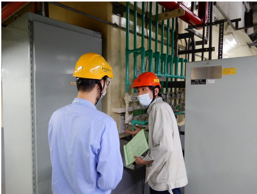
原能會視察員查核 2 號機反應器廠房設備狀況
