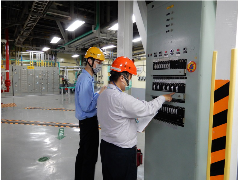
原能會視察員查核 1 號機反應器廠房設備狀況
