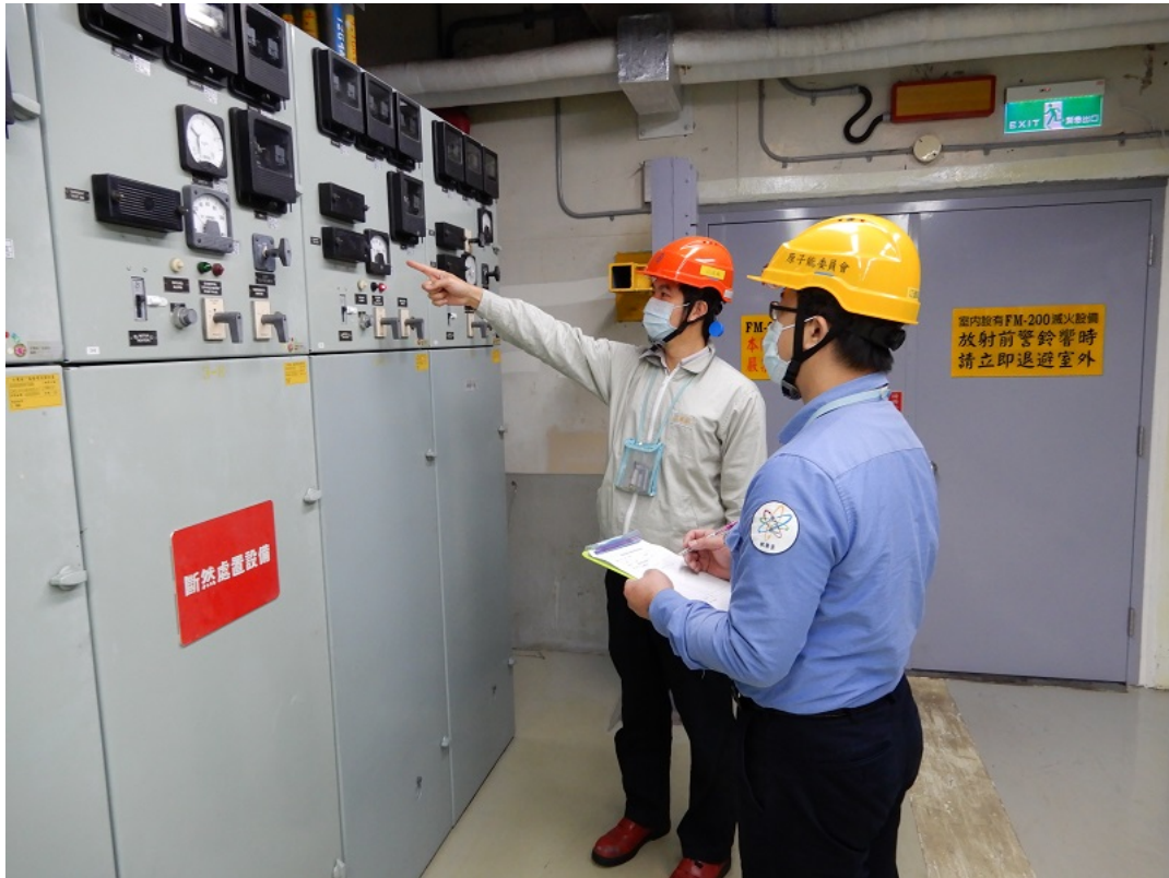
原能會視察員查核 1 號機反應器廠房現場設備狀況
