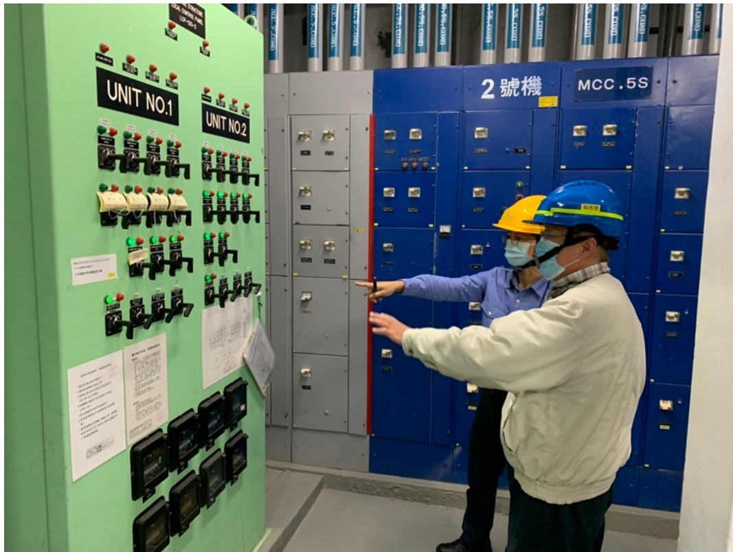
原能會視察員查核海水泵室現場設備狀況
