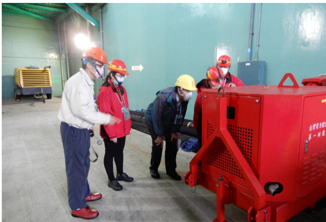
本會視察員現場視察消防設備維護情形
