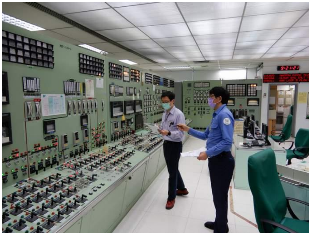
本會視察員於 2 號機主控制室查核運轉值班人員機組掌握狀況
