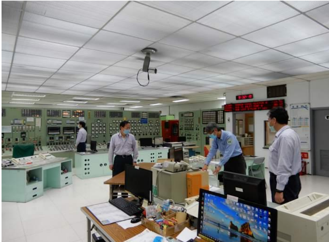
本會視察員於 1 號機主控制室查核運轉值班人員機組掌握狀況
