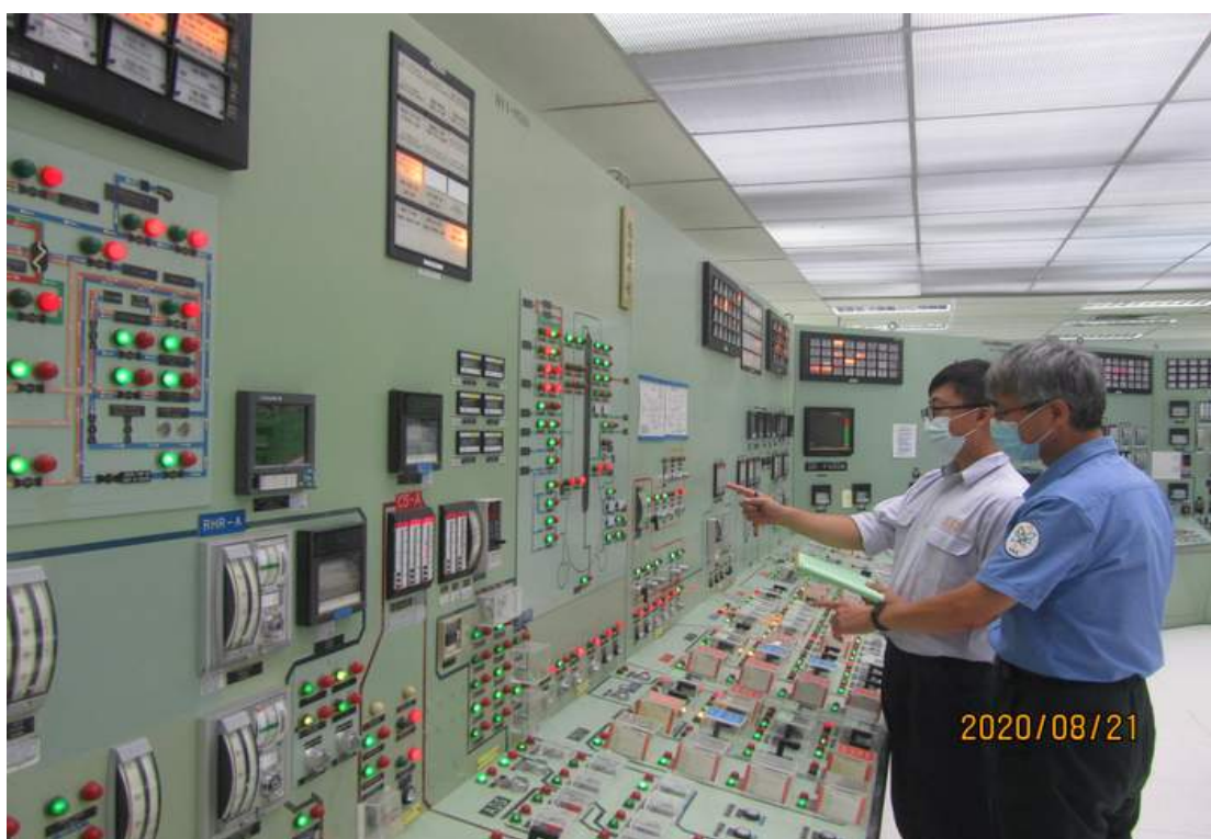
本會視察員於 2 號機主控制室查核運轉值班人員機組掌握狀況
