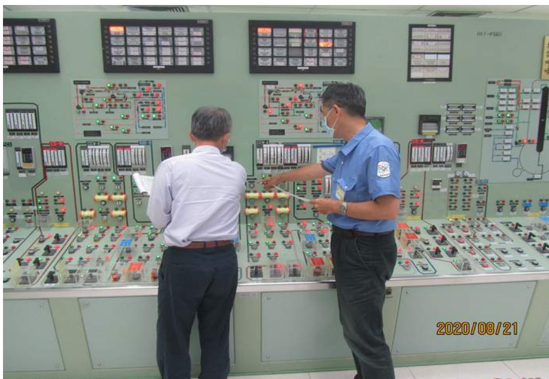
本會視察員於 1 號機主控制室查核運轉值班人員機組掌握狀況
