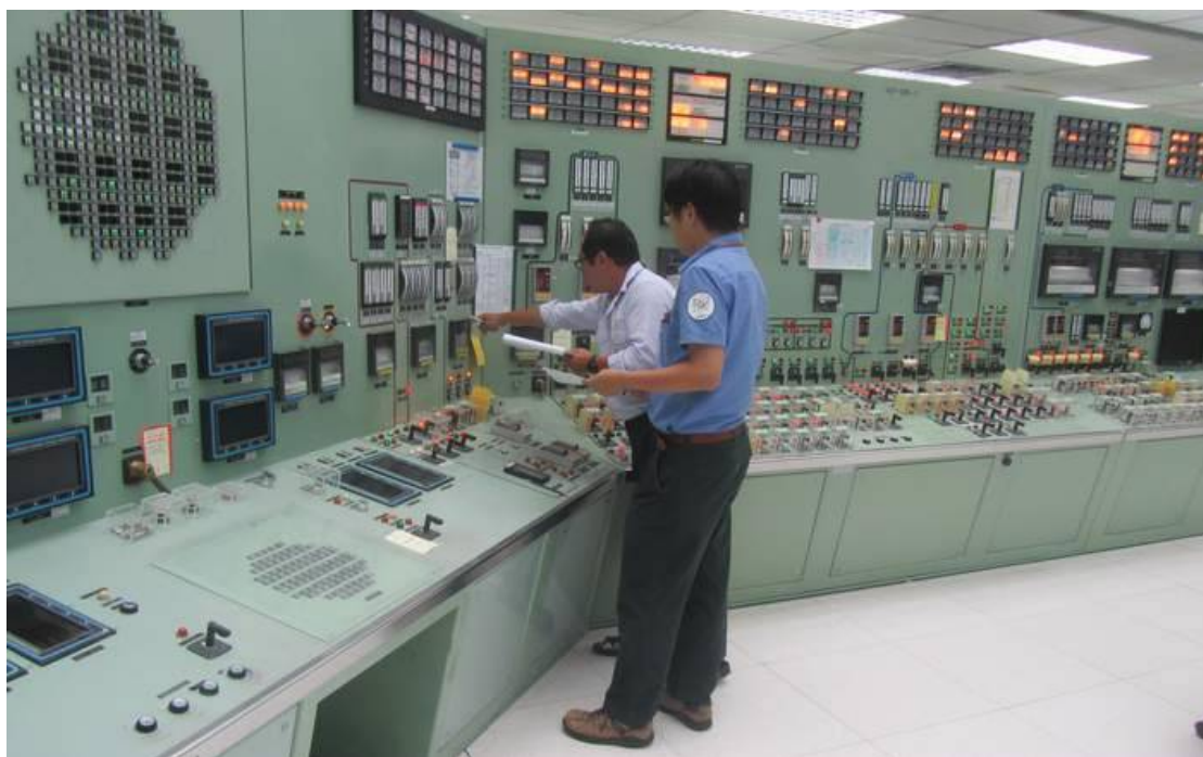
本會視察員於 1 號機主控制室查核運轉值班人員機組掌握狀況
