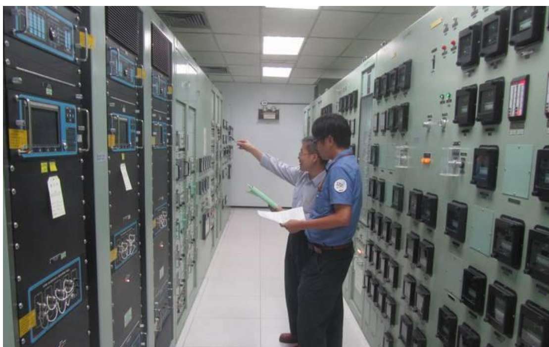
本會視察員於 2 號機主控制室查核運轉值班人員機組掌握狀況
