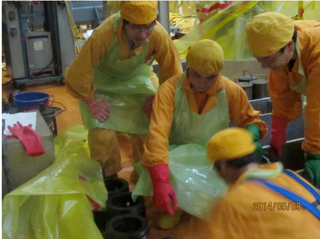
照片 3 視察 RPV 爐蓋 Nuts 與 Washers 執行 VT-1 目視檢測作業
