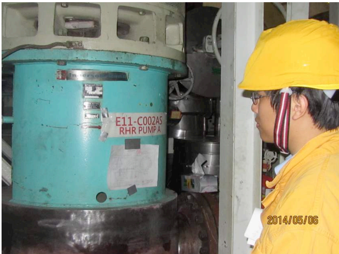
照片 2 視察 RHR 泵殼執行 ISI 之液滲檢測作業
