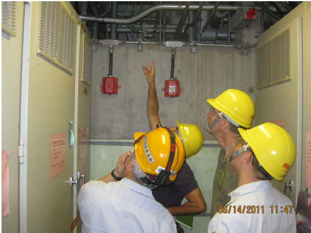
在 RB EL. 4800 檢查 RMU 室與安全電氣室間電氣實體隔離情形
