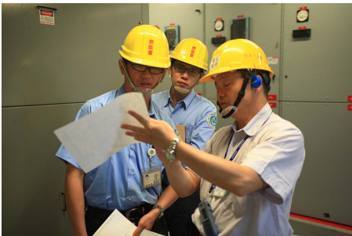
照片 4:測試期間現場作業視察
