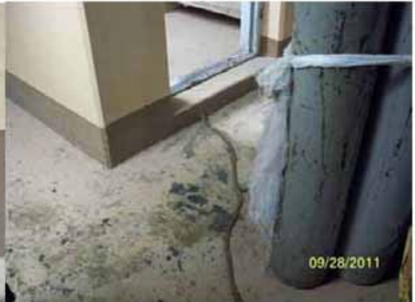
二號機反應器廠房 1F 西北側樓梯間：地面接地銅線凌亂，未使用線夾整齊固定於牆邊，有工安疑慮，且疑似未依施工規範施工。
