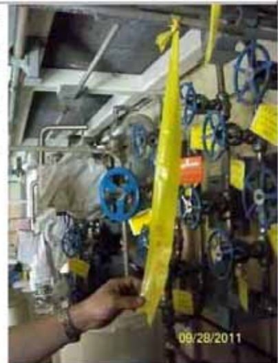
#2 DIV. II 儀器架室：管線支撐座固定螺栓懸空，無水泥砂漿基座，能否發揮原設計支撐功能恐有疑義。
