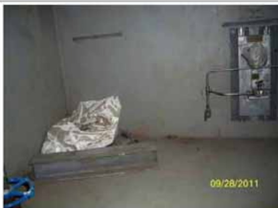
2E11-BV-0552C RHR C 主泵 1C 外側洩水閥附近空間堆置工料、零件，不符廠務管理規定。
