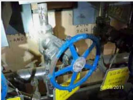
#2 DIV. II 儀器架室：2C12-FT-0006 內側隔離閥轉盤表漆脫落、銹蝕。
