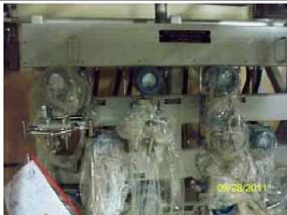
2H21-IRK-0117 儀器盤未完全披覆防塵布，但三天前(9 月 25 日)廠商檢查紀錄覆蓋物完整項目卻打勾，疑似未確實檢查。
