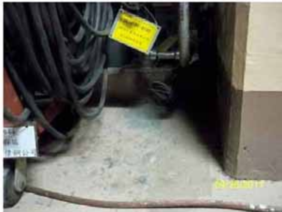
二號機反應器廠房 1F 西北側樓梯間：地面接地銅線凌亂，未使用線夾整齊固定於牆邊，有工安疑慮，且疑似未依施工規範施工。
