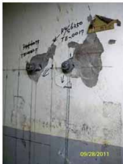
#2 DIV. II 儀器架室：2C12-FT-0006 內側隔離閥轉盤表漆脫落、銹蝕。
