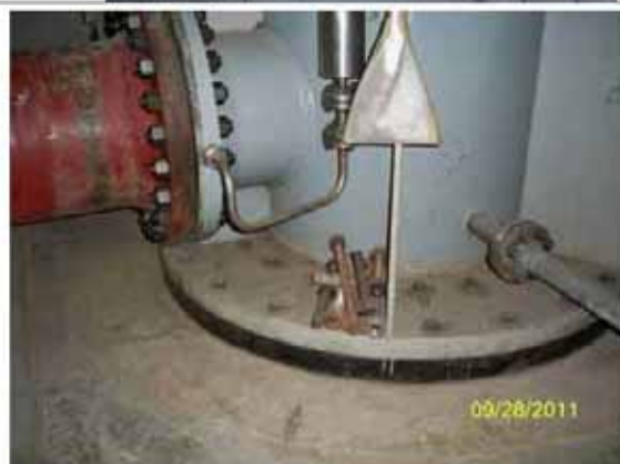
2E11-BV-0552C RHR C 主泵 1C 外側洩水閥附近空間堆置工料、零件，不符廠務管理規定。
