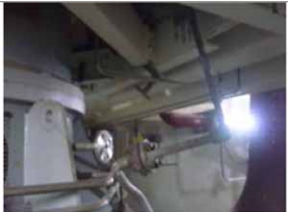
進行管路沖洗時將管線加工彎折
