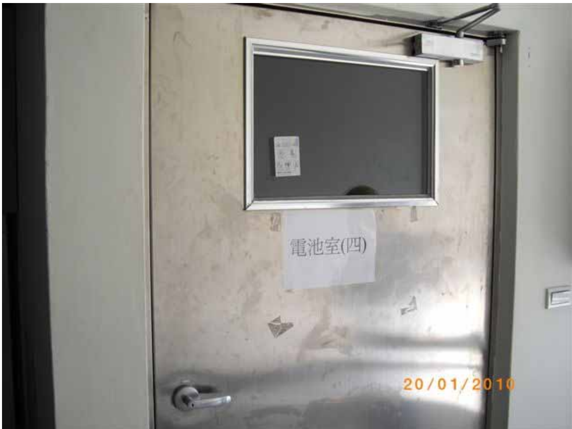
照片 5 開關場電池室防火門現況
