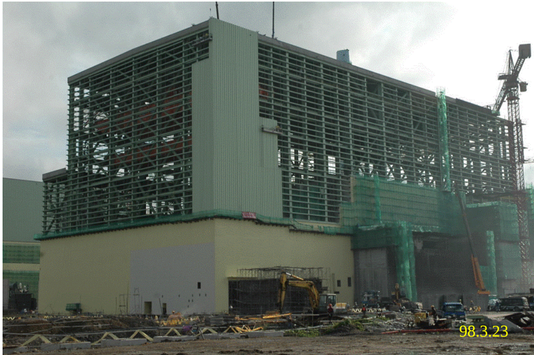
照片五：二號機汽機廠房施工現況
