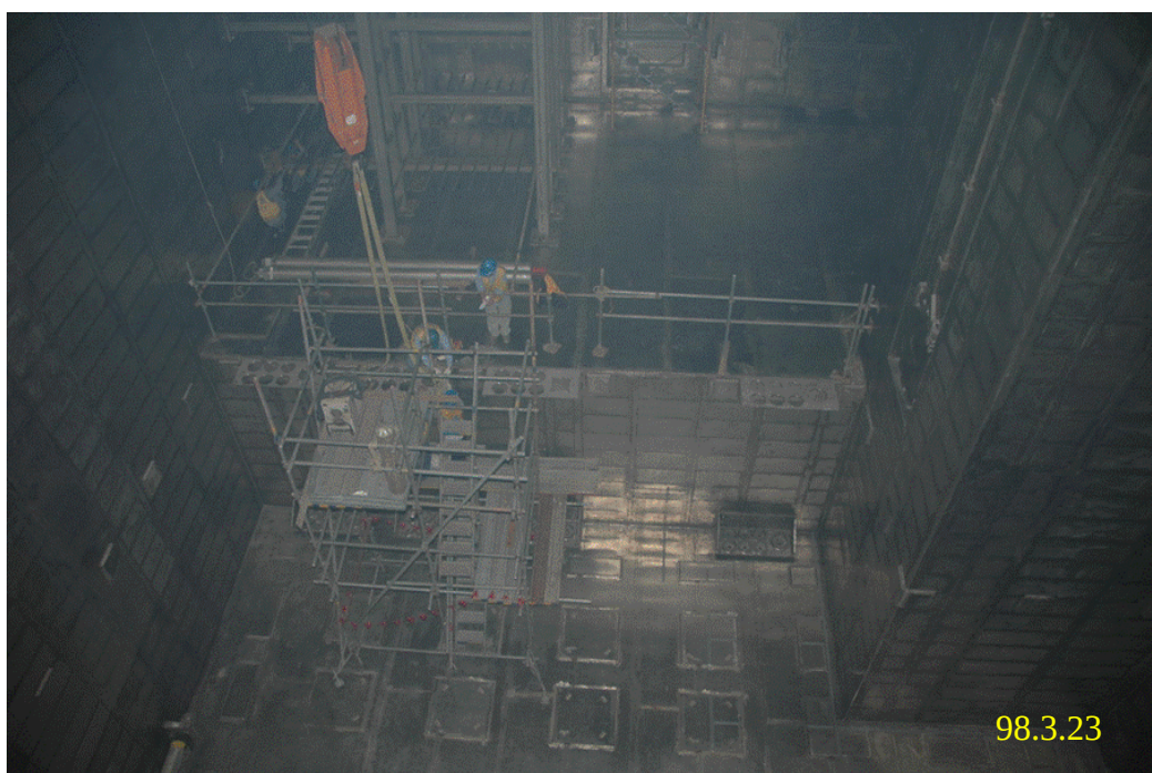
照片二：一號機反應器廠房用過燃料儲存池格架安裝施工現況
