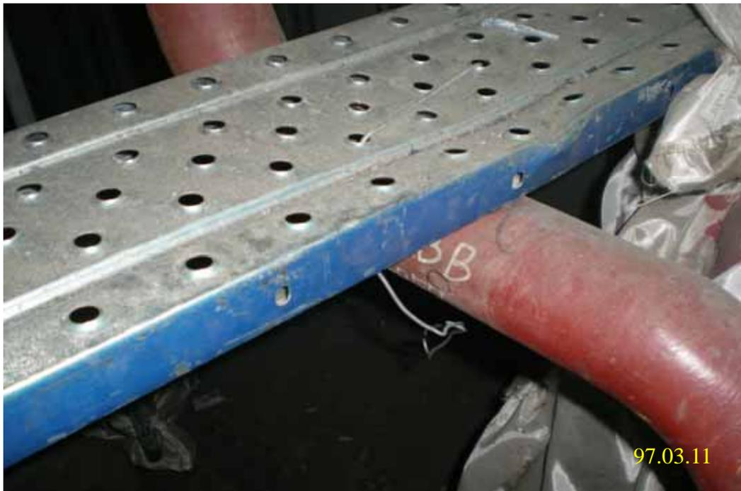
照片八：一號機 RHR 止回閥之平衡閥管路置放工作架情形
