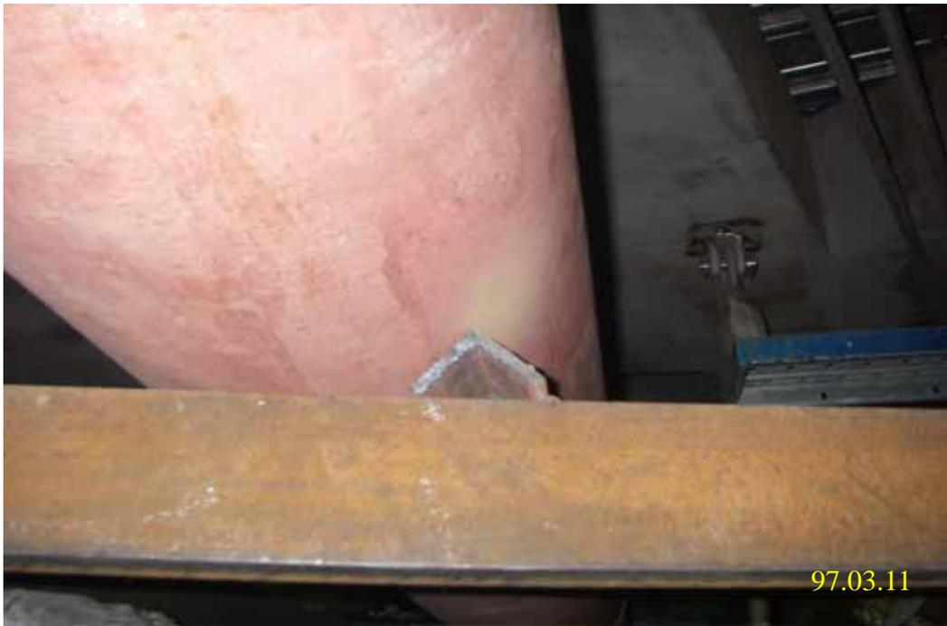
照片七：一號機飼水管路以銳角性之鐵件作臨時支撐情形
