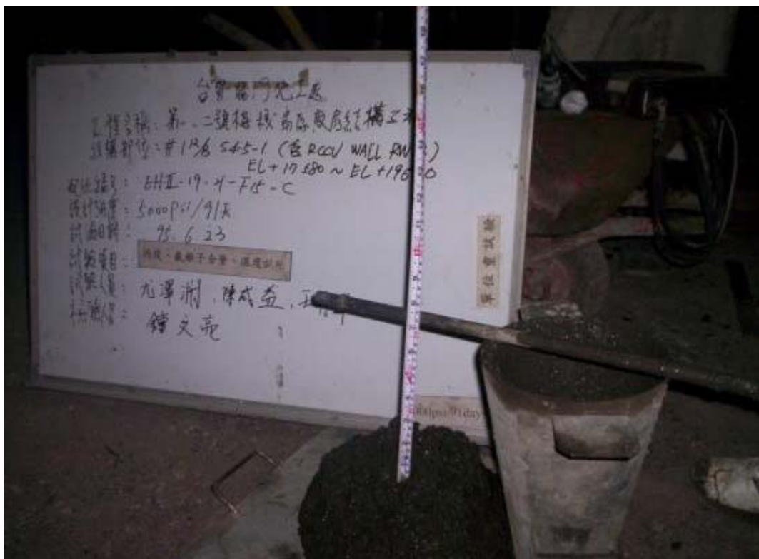
圖 10：混凝土取樣試驗作業情形
