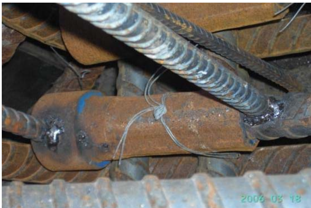
圖 2：埋件支撐銲接於鋼筋上情形
