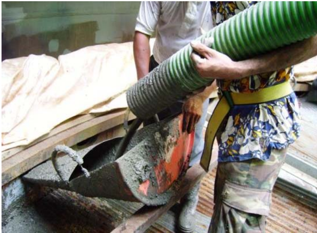
圖 5：二號機基座之 RPV 支撐座澆置情形
