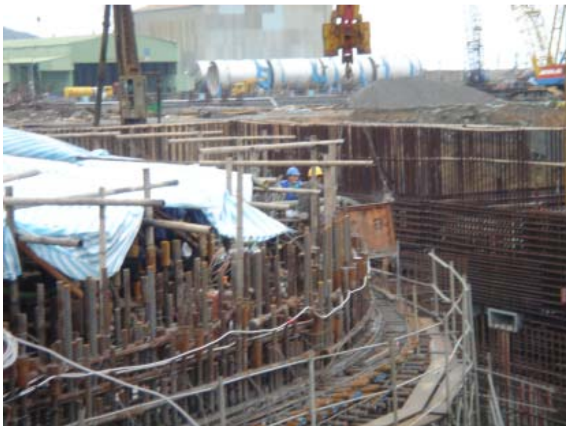
圖七：一號機隔膜地板澆置前進行水泥砂漿管路潤管並運棄作業
