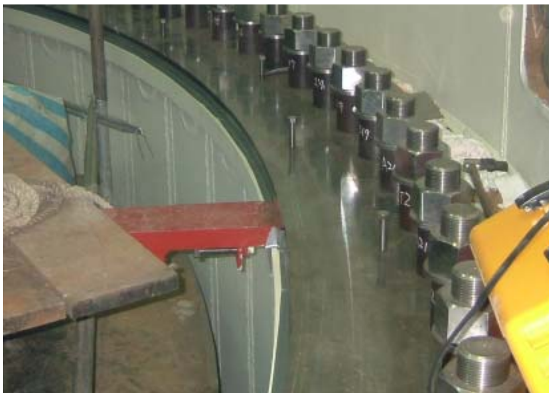
圖十三：半圓形開口封銲後情形
