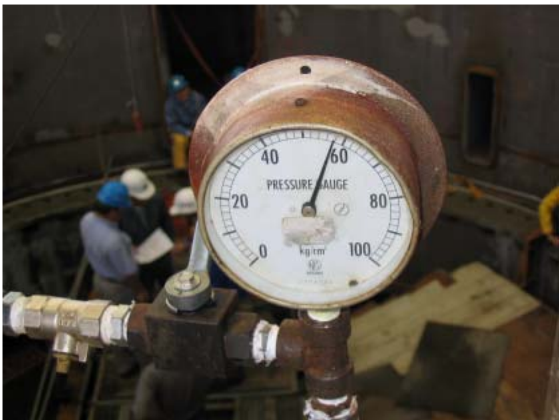
圖二：SRV VENT PIPE 水壓測試情形
