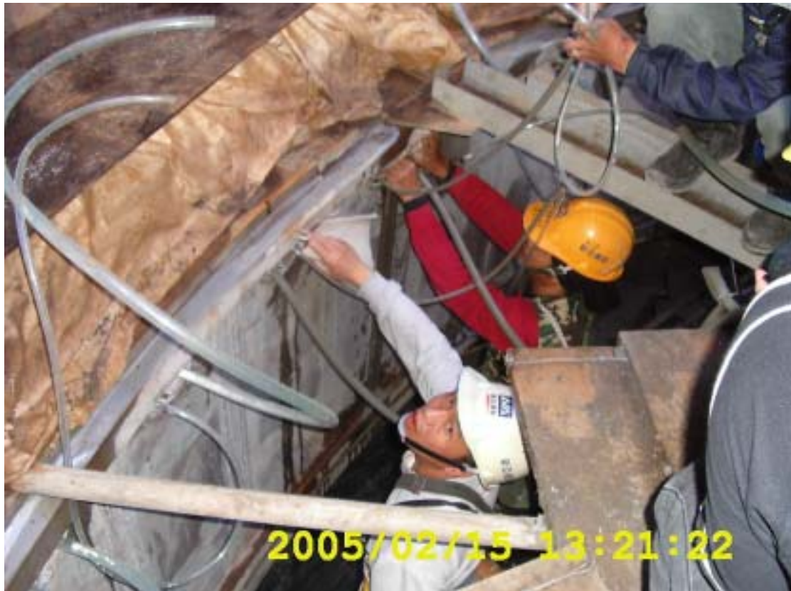
圖十一：半圓形開口處封板插塑膠管 以不收縮水泥漿壓力灌漿作業情形
