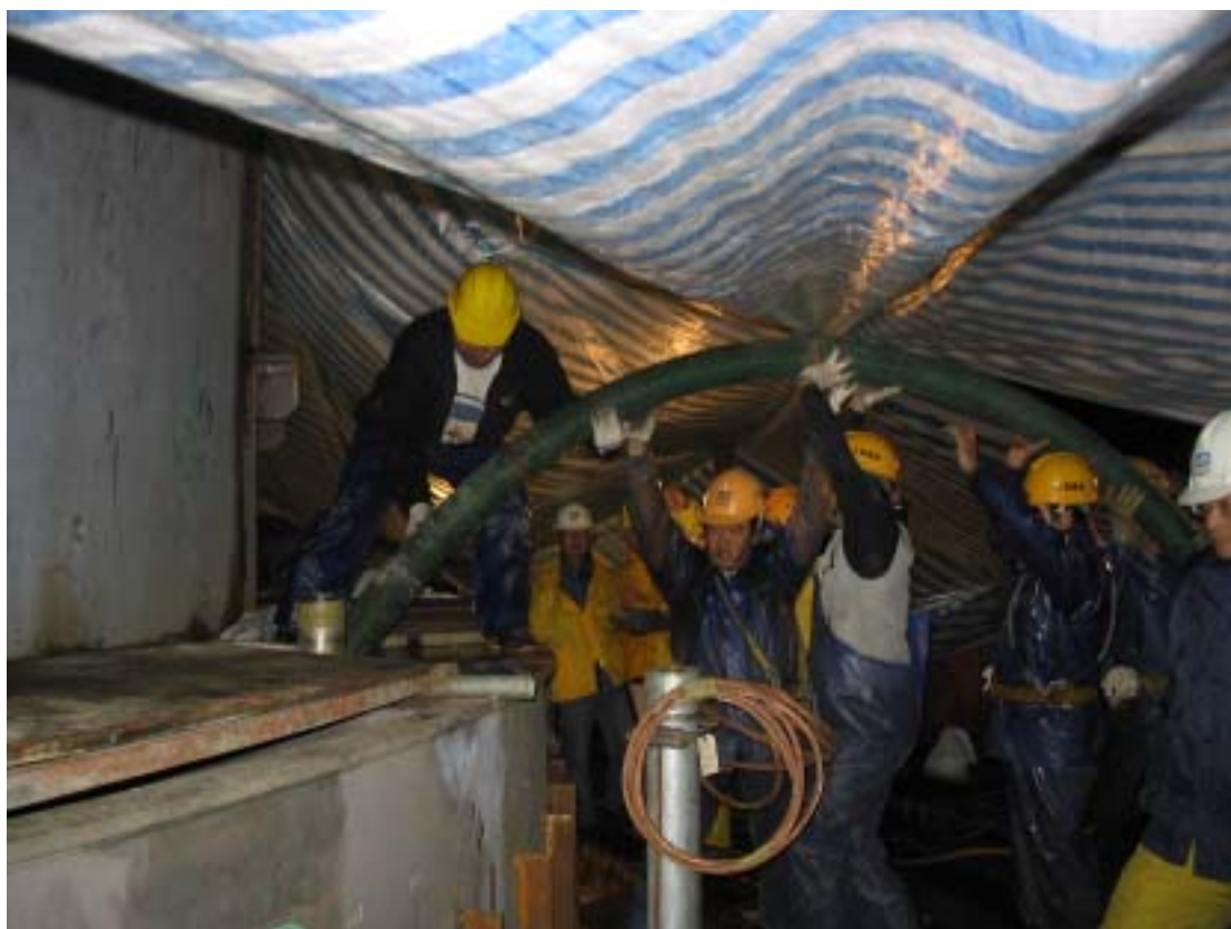
圖十：一號機基座第三次澆置(外環)作業情形
