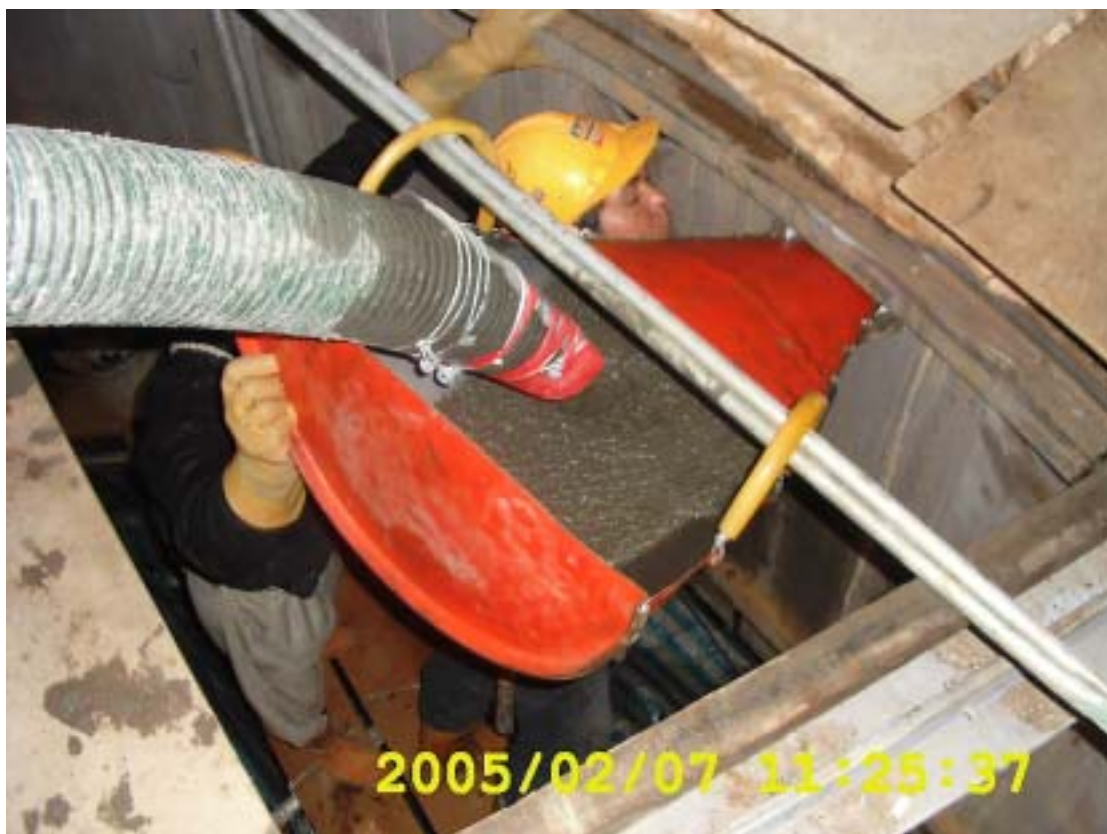
圖八：一號機基座第四次澆置於半圓形開口澆置作業情形
