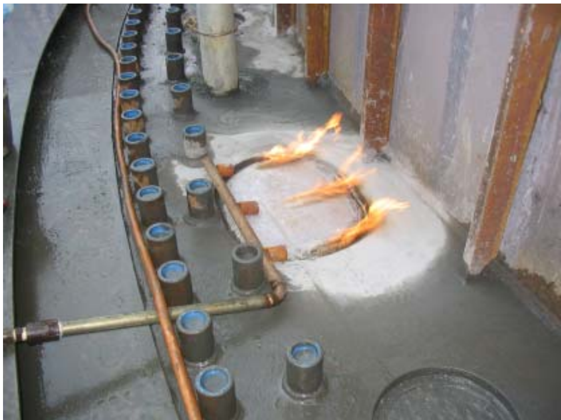
圖四：澆置後養護中準備進行人孔封鐸之預熱除水作業
