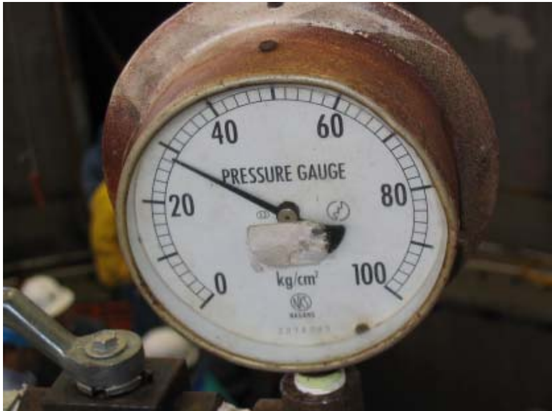
圖三：SRV VENT PIPE 降壓後持壓檢查洩漏之水壓測試情形
