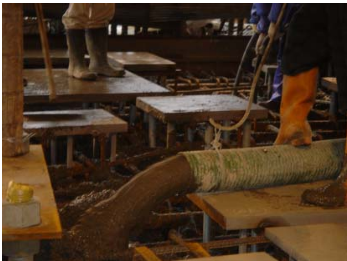
圖九：一號機隔膜地板混凝土澆置作業情形
