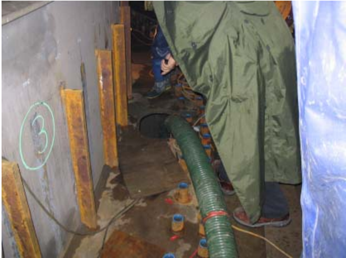
圖五：奇異公司變更設計新增 160 支剪力鉚設置情形
