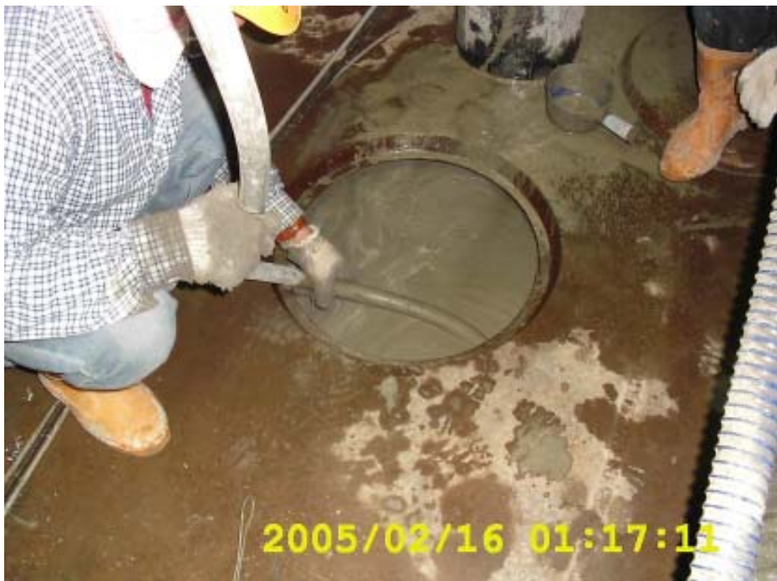
圖十二：頂板開口不收縮水泥漿壓力灌漿作業情形
