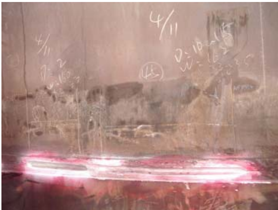
圖二：WN23 鐸道缺陷(第 45 號)磨除後情形
