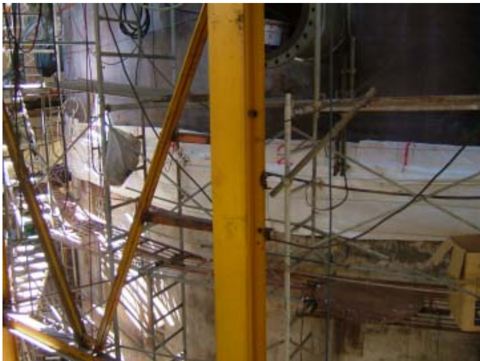
圖十二：整圈鐸道同時執行鐸後熱處理作業情形
