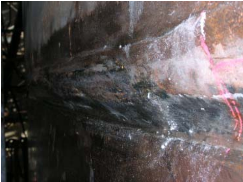
圖十：WN23 鐸道高低落差情形
