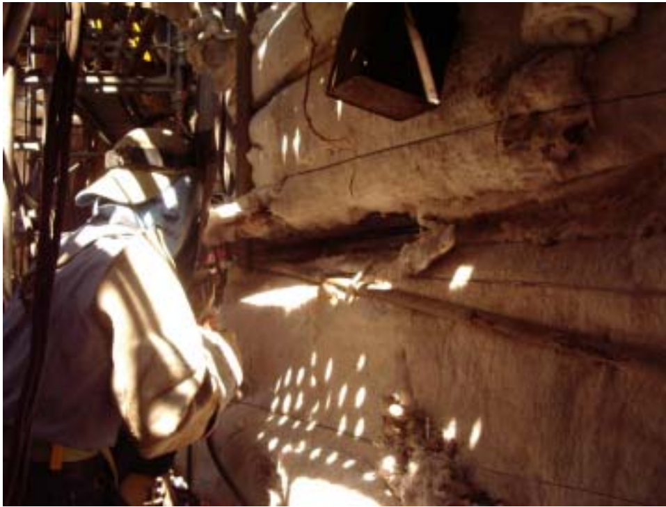
圖三：第一次試鐸作業情形(第 21 號缺陷)
