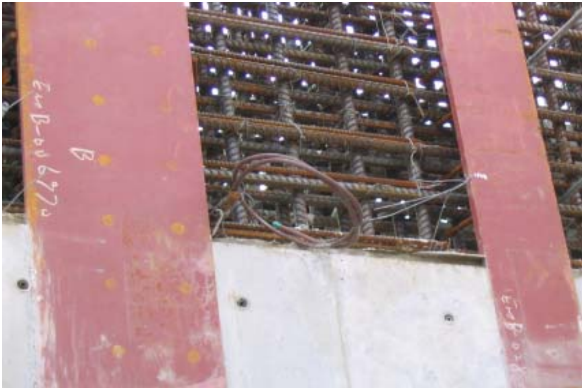
照片一：一號機反應廠房東側牆之預埋接地線
