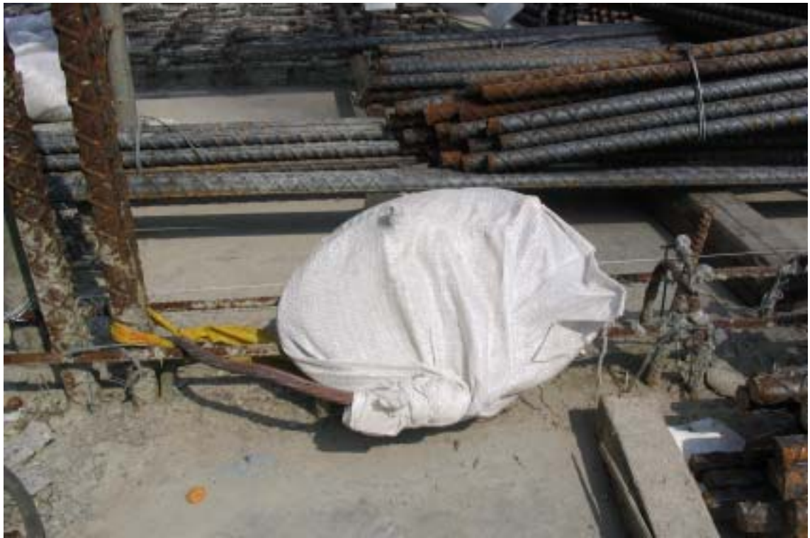
照片三：一號機反應廠房 EL+4800 之預埋接地線（一）
