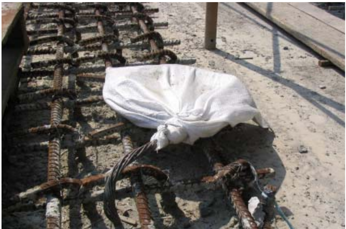
照片二：一號機反應廠房 EL+4800 之預埋接地線（二）
