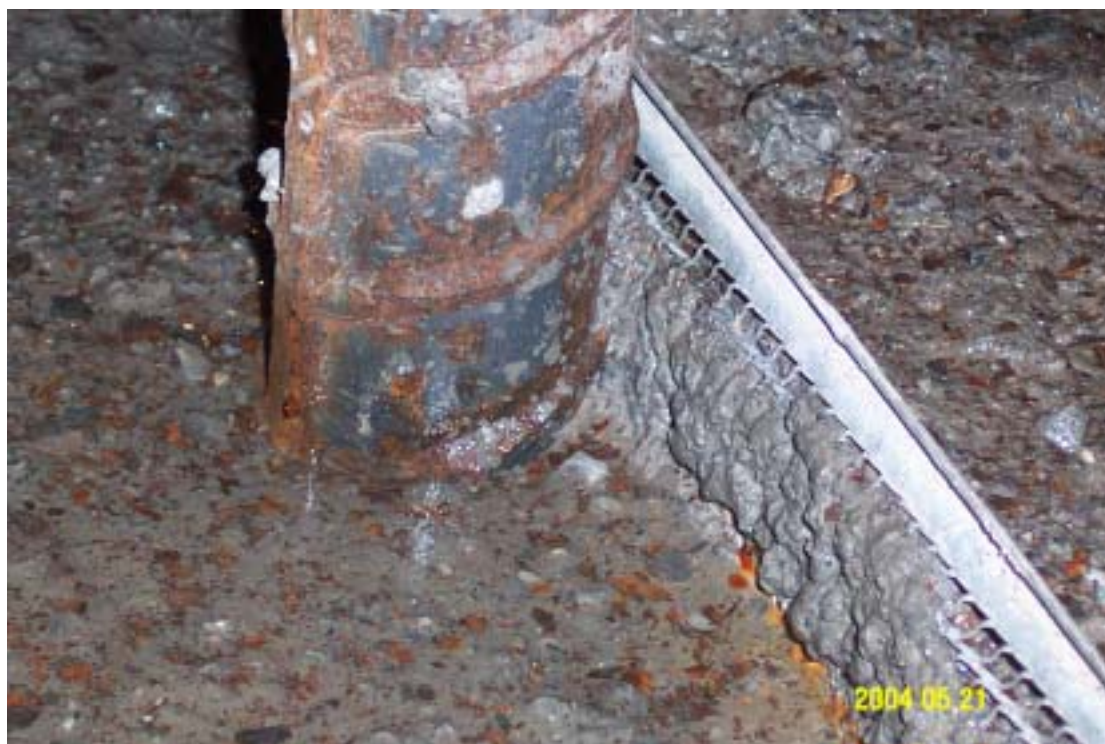
圖四：施工凸樁尺寸改善後情形
