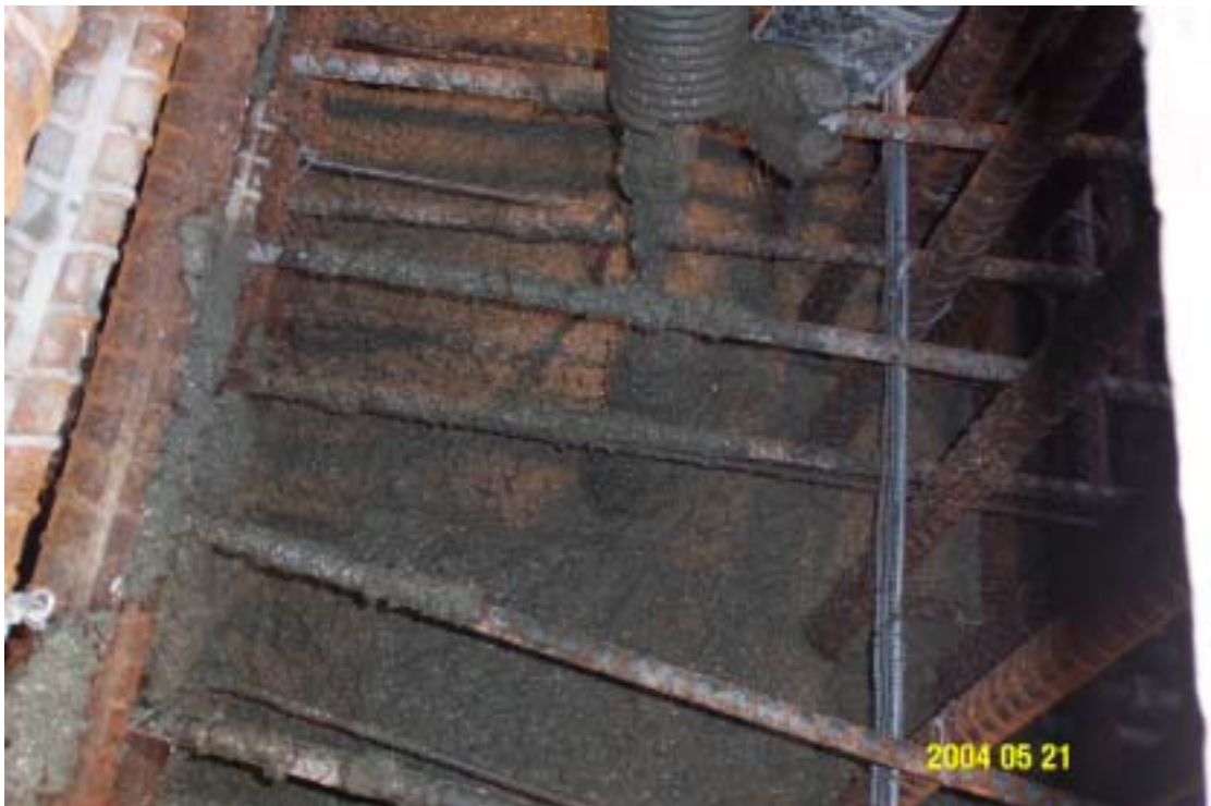
圖十：現場進行混凝土澆置作業情形
