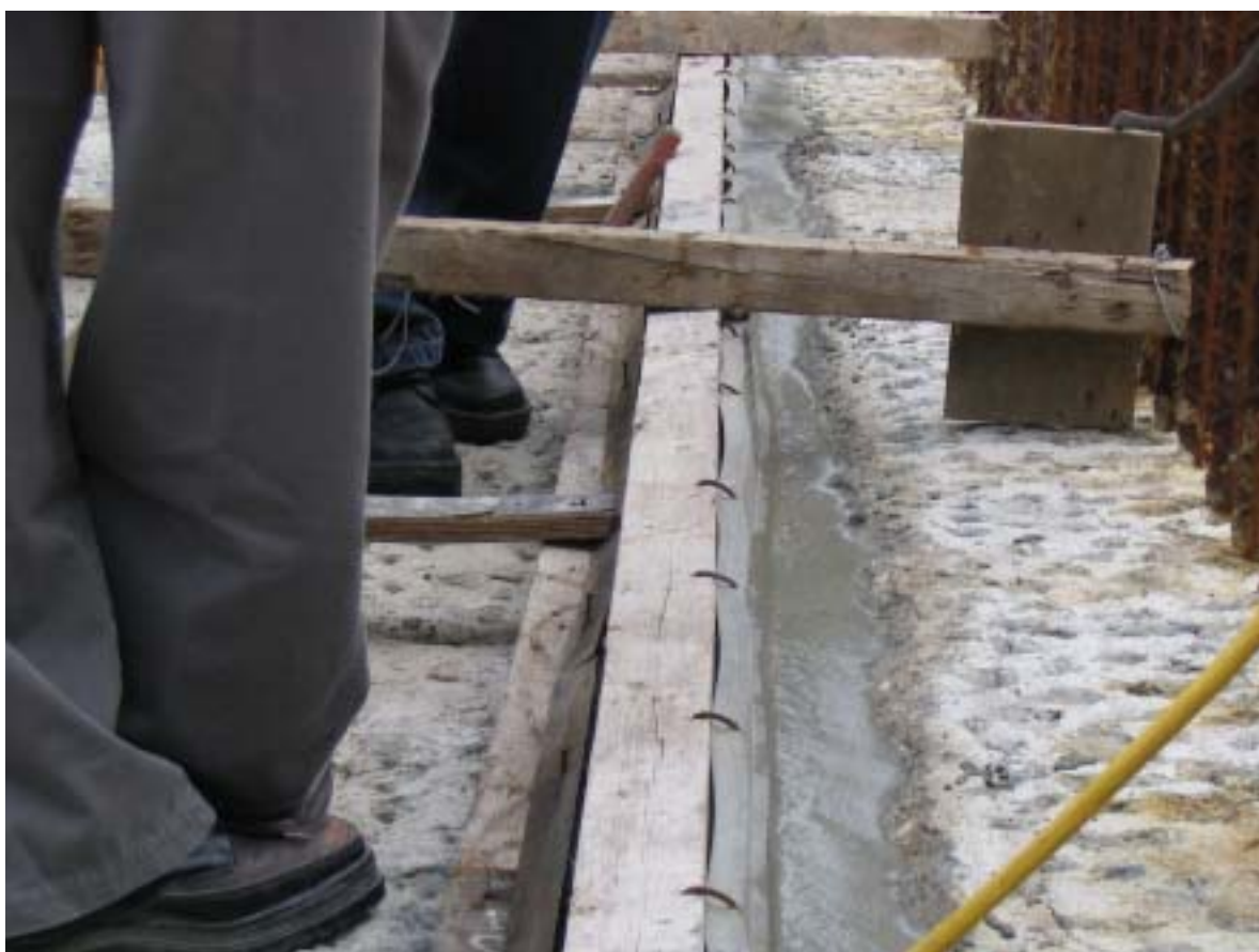
圖十六：CWPH 基座第二區塊止水帶改善不當的單側施工情形
