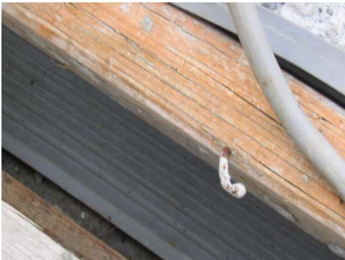
圖十五：CWPH 基座第二區塊止水帶偏斜情形
