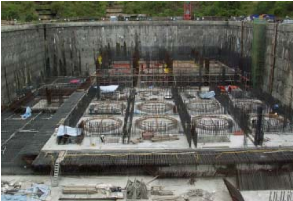
照片五：核廢料廠房施工現況
