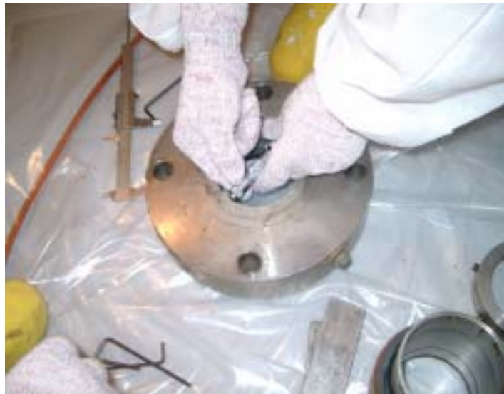
量測各零件運轉間隙及泵上、下軸直度(二)
