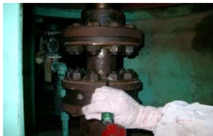
泵與馬達之連軸器組裝及機械軸封壓縮量設定完成
