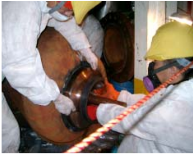
拆除第一級動葉輪
