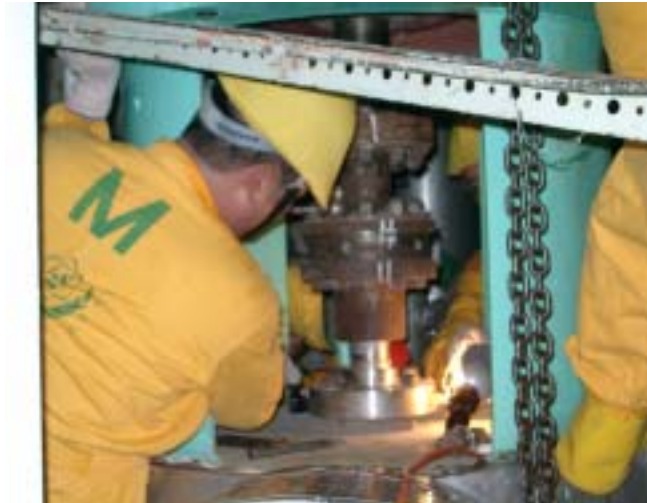
工作人員進入現場，拆卸馬達與泵間之 COUPLING
