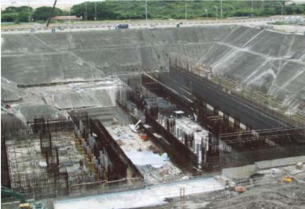
照片五：二號機汽機廠房施工現況
