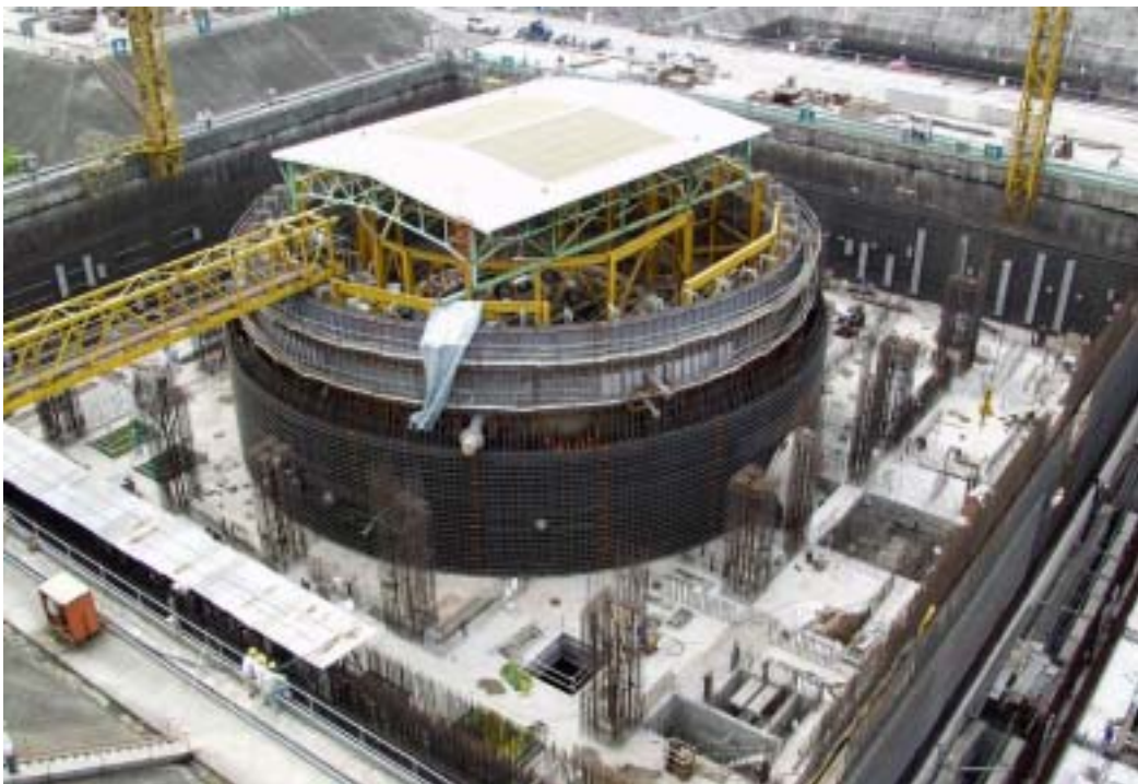
照片二：一號機反應器廠房施工現況
