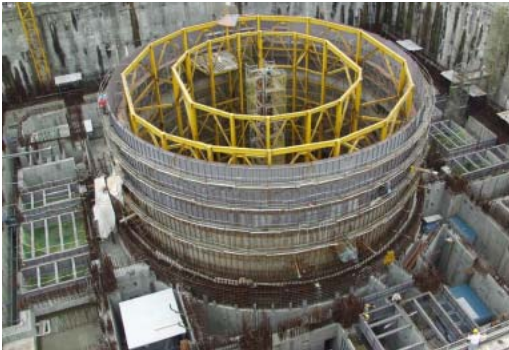
照片四：二號機反應器廠房施工現況
