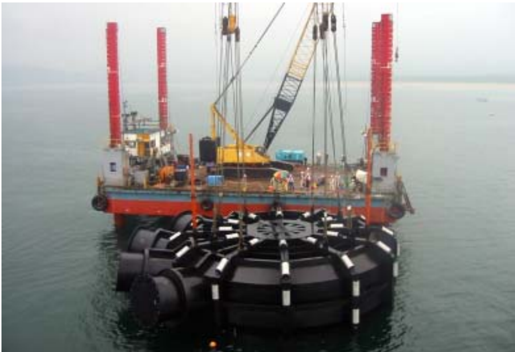
照片六：出水道工程到達井排水頭施工情形
