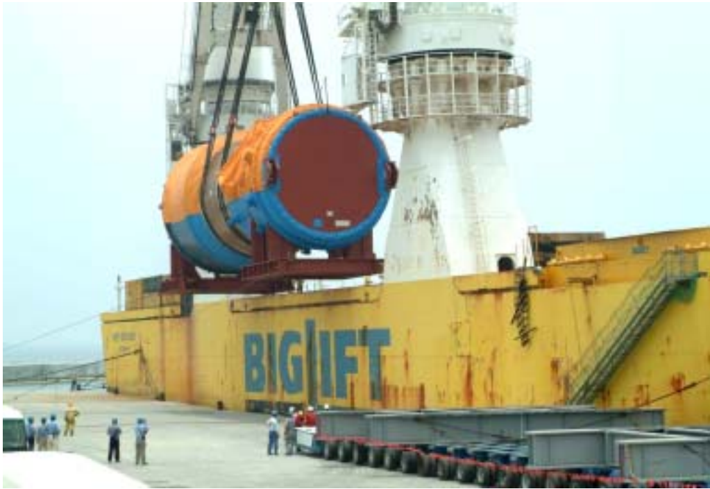
照片七：一號機核反應器吊運情形
