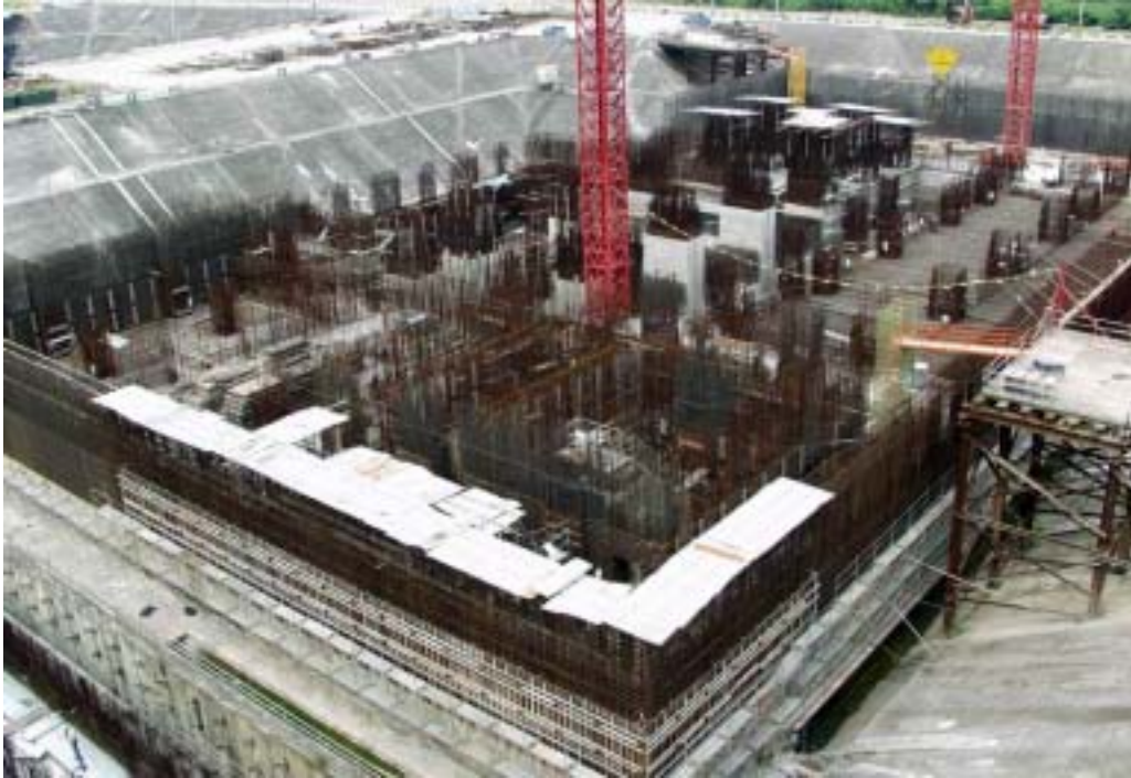
照片三：一號機汽機廠房施工現況
