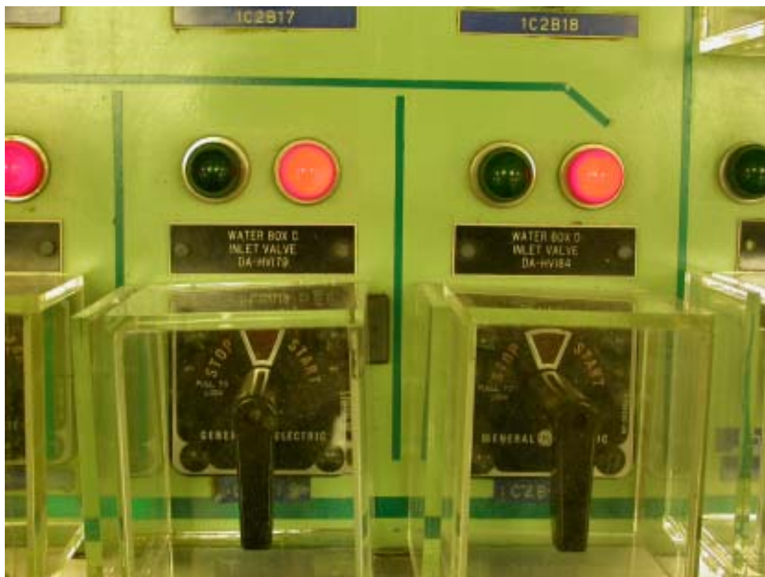
圖二、主控制室冷凝器水箱 D 海水進口閥 1DA-HV-184 之控制開關
