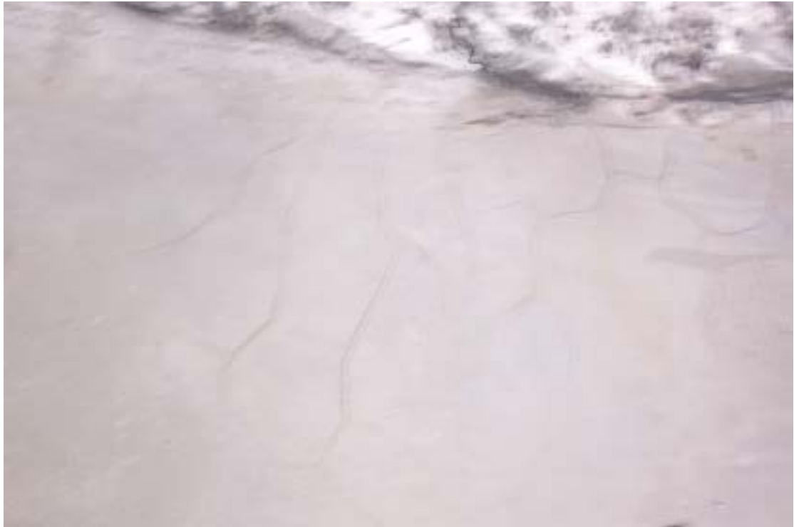
圖十三：局部完成面發生乾縮裂紋情形
