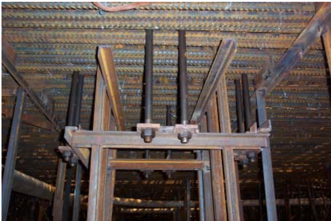
圖二：鋼筋間距改善後情形
