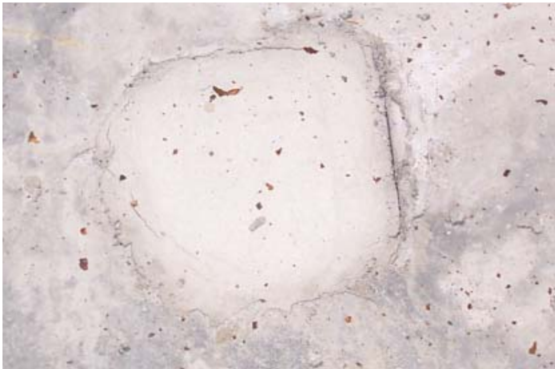
圖十四：工作角鋼切除以混凝土修補後形狀不規則 且邊緣均發生裂縫之情形
