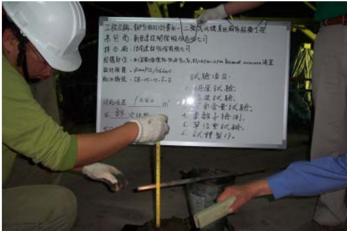
圖五：混凝土坍度試驗現況（4/1 01：10）
