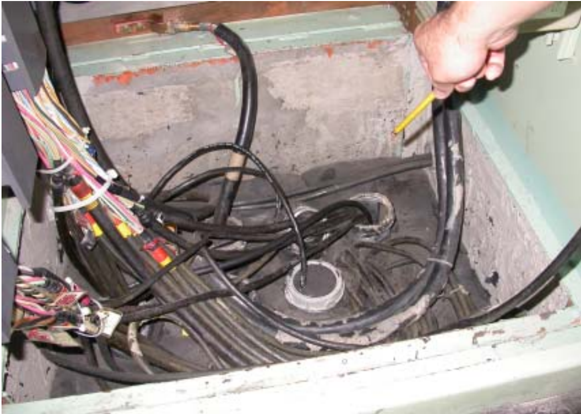
照片五 開關箱內儀電穿越管端頭，無完整塗敷防火絕緣材料
