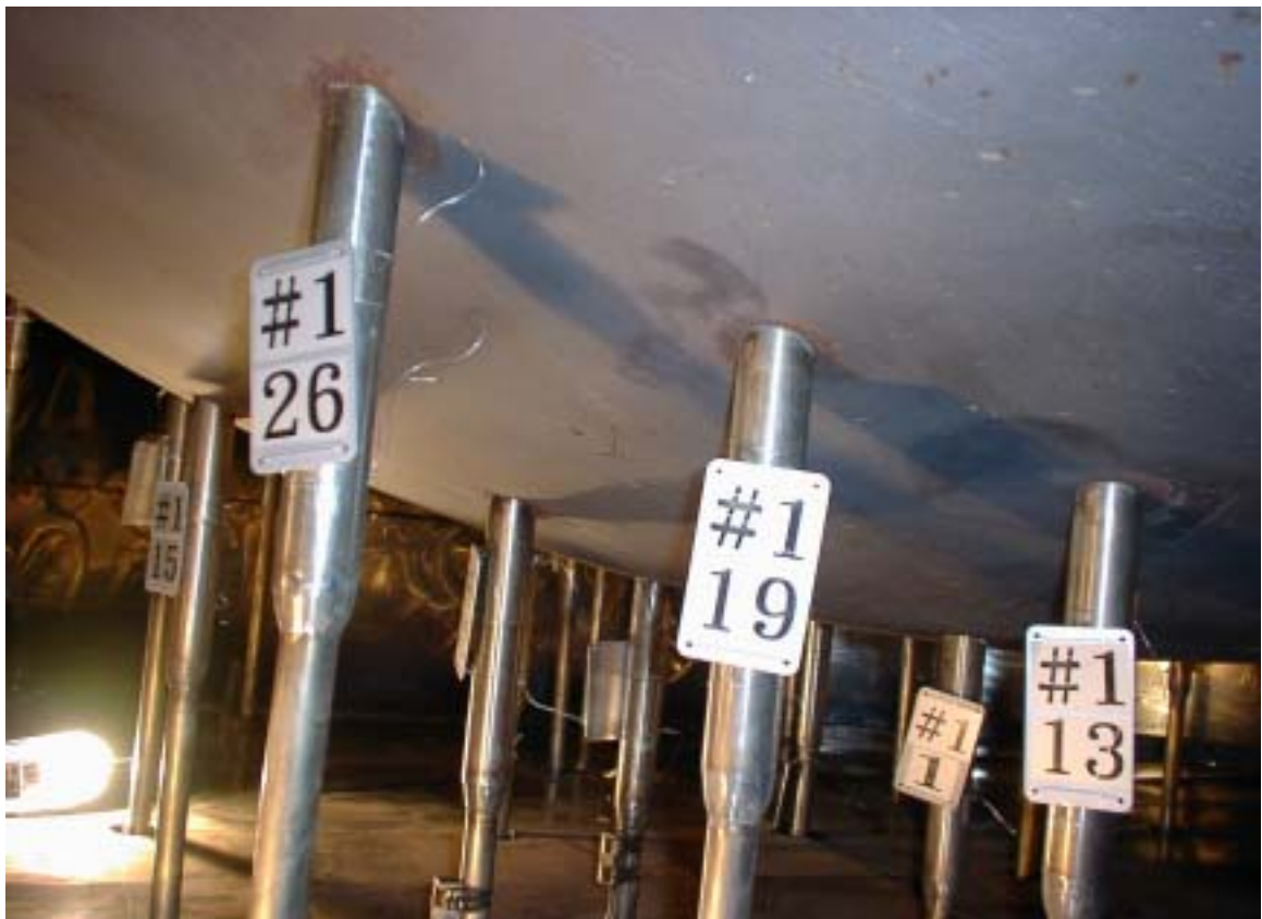
相片十八 一號機反應器爐底清洗後的情況
