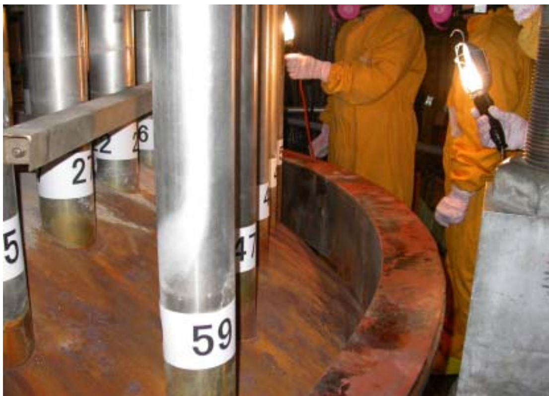
相片五 一號機反應爐爐蓋 CRDM 穿越管現場查證之一
