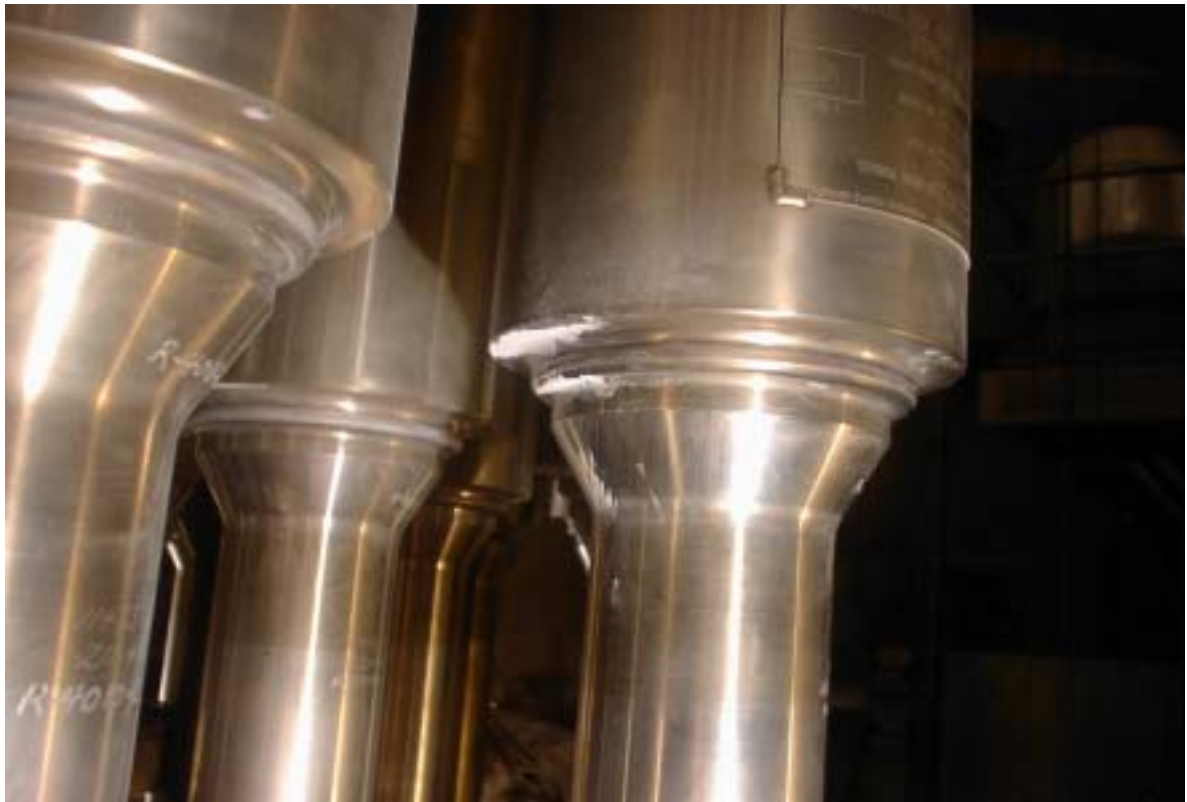
相片八 穿越管 #58 於 CANOPY SEALWELD 處靠內側有白 色均勻粉狀物質
