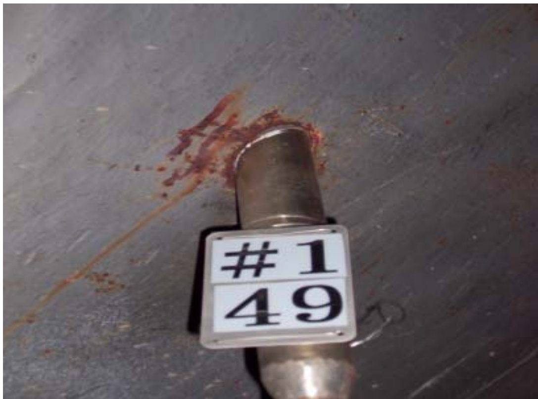
相片十四 一號機爐底儀器穿越管有白色附著物情形
