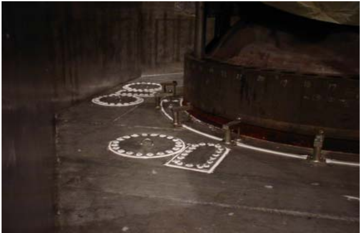
相片十七 反應器爐外核儀人孔蓋位置圖
