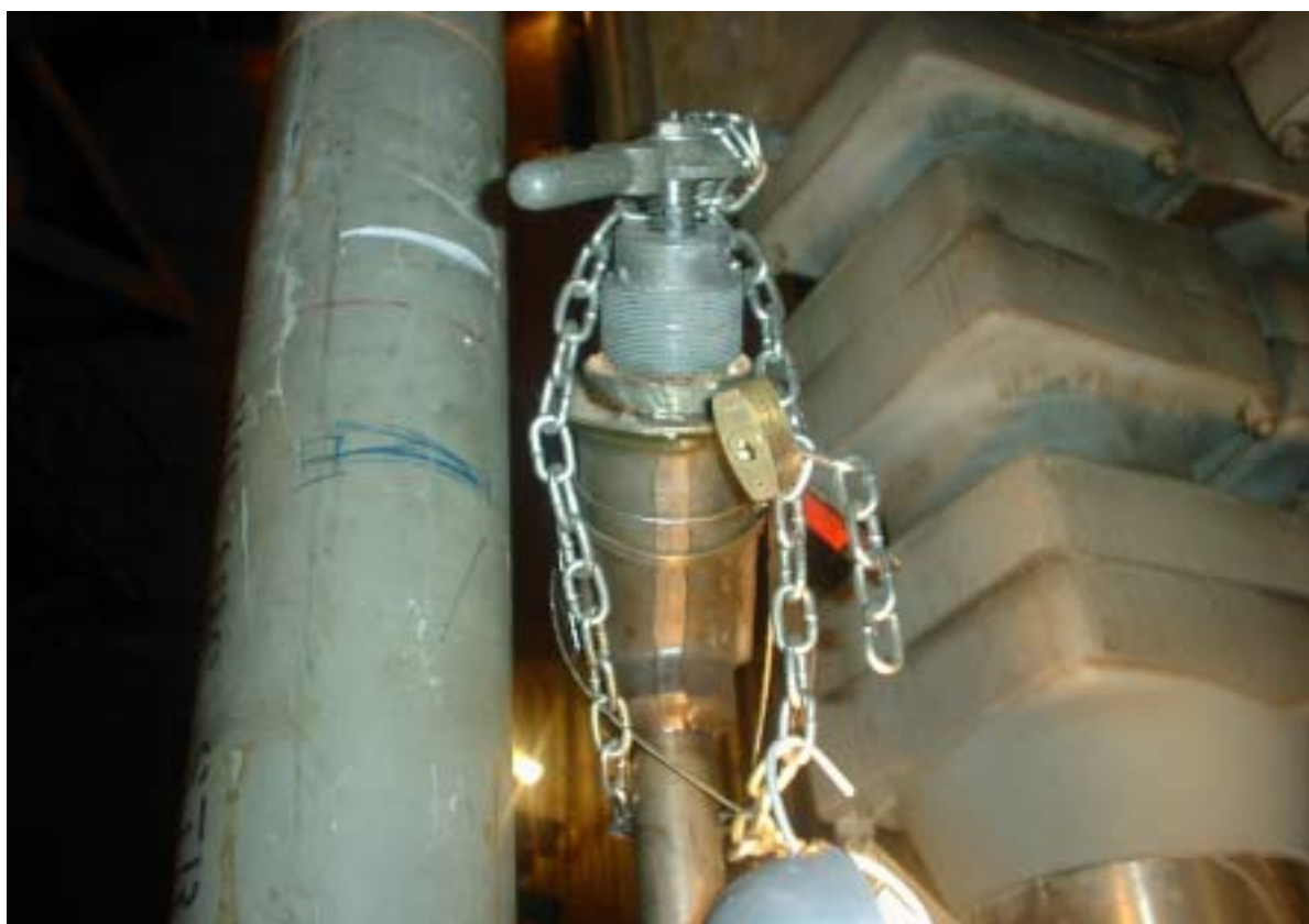
相片十 爐蓋旁 BB-V089 發現閥帽處有洩漏痕跡
