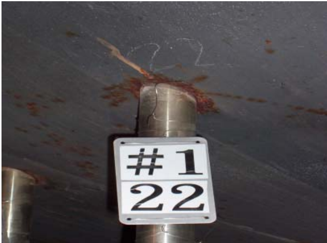
相片十五 一號機穿越管白色附著物與交接面有一小段清潔帶情形
