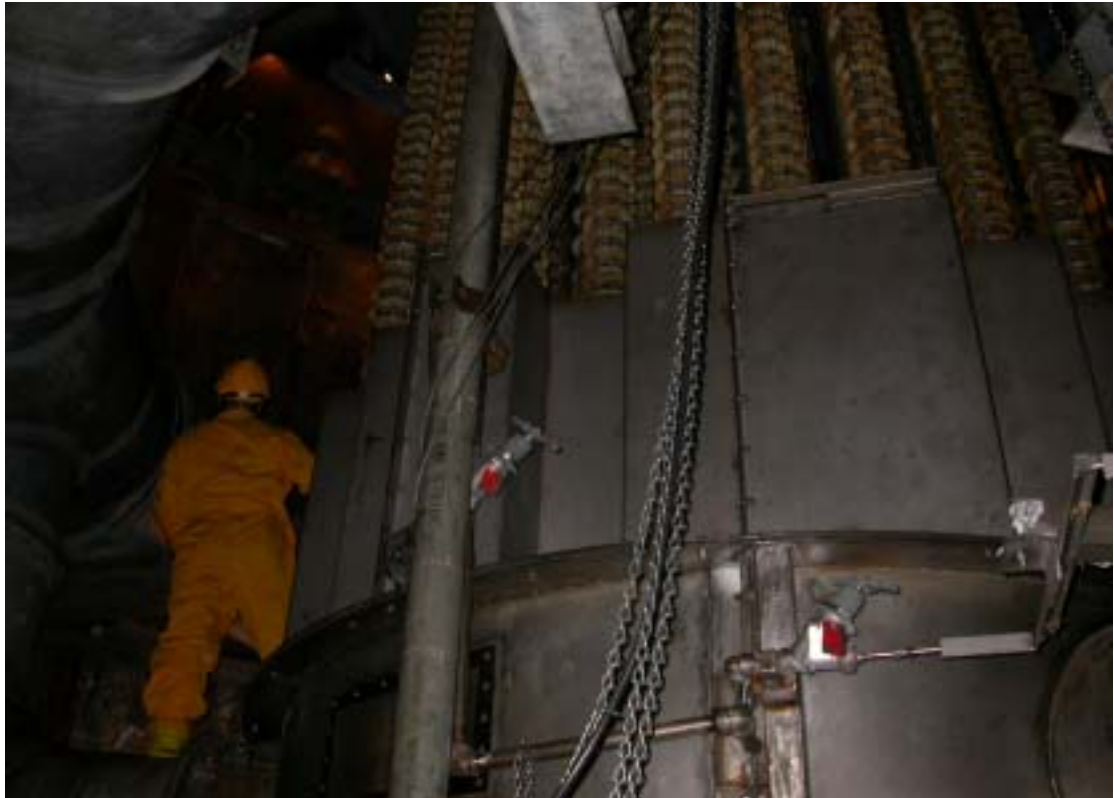
相片十一 一號機反應爐蓋回裝補水加壓現場檢查
