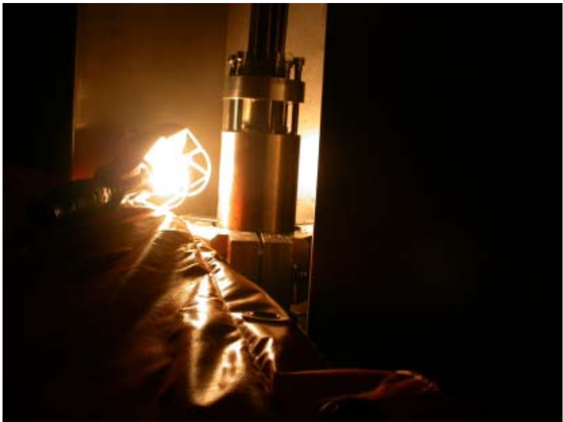
相片十二 一號機熱電偶穿越管 Conoseal 洩漏現場檢修情形
