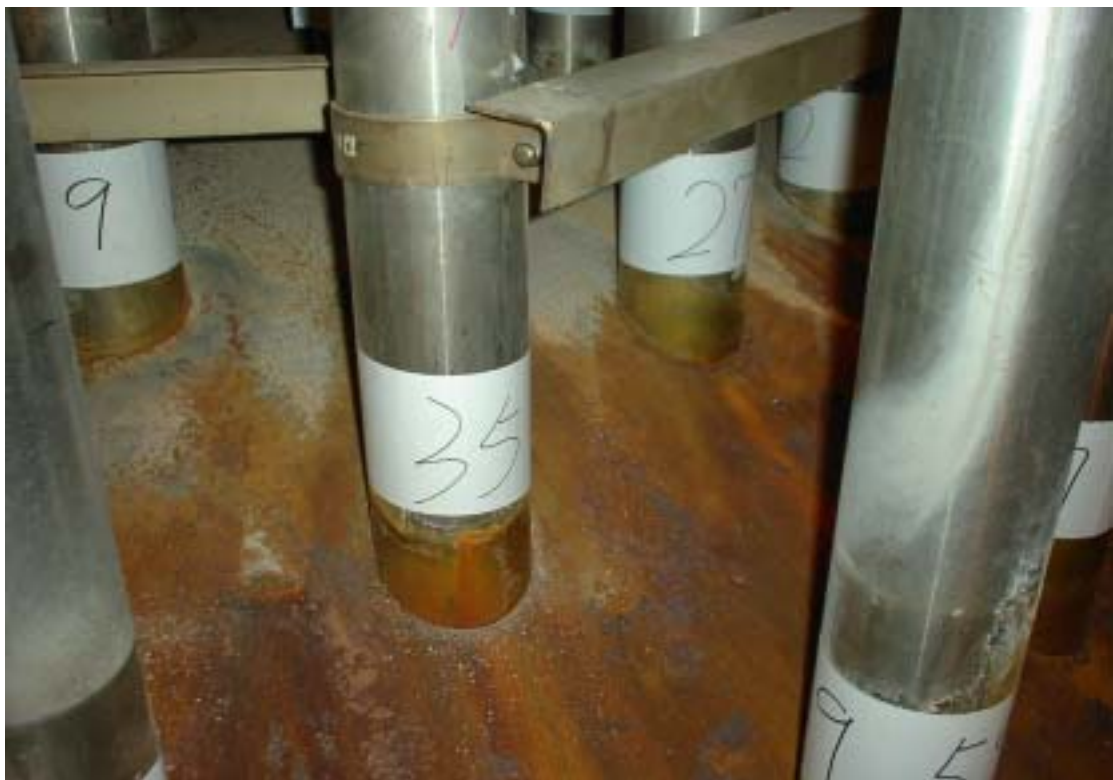
相片二 一號機 EOC-13 大修爐蓋與相片一同位置外表面狀況
