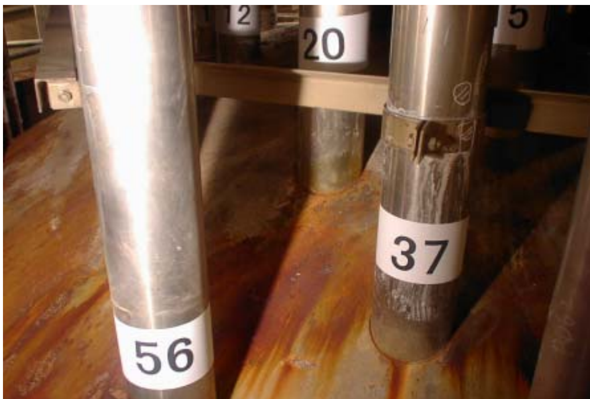
相片九 一號機穿越管 #37 於穿越管中段有明顯白色水痕
