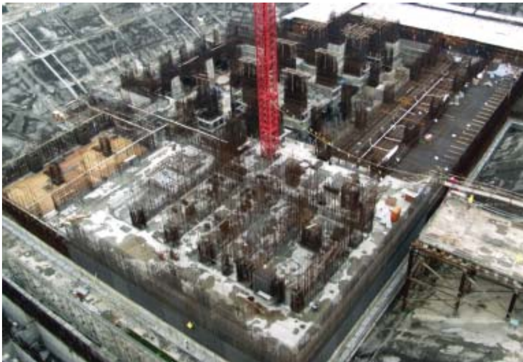
照片三：一號機汽機廠房施工現況
