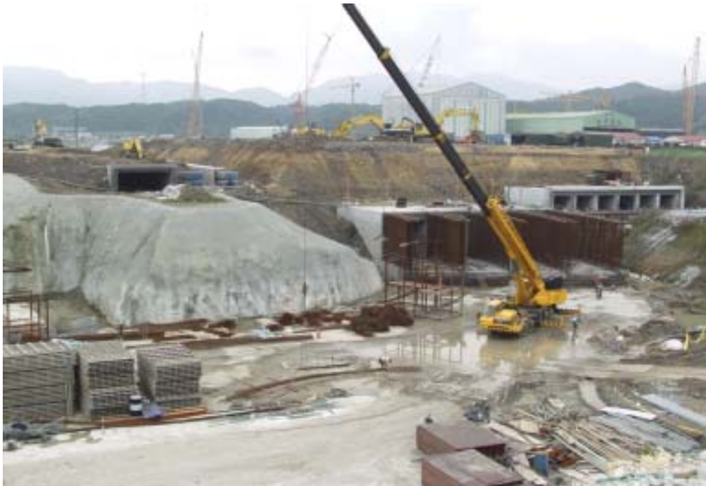
照片五：進水暗渠施工現況
