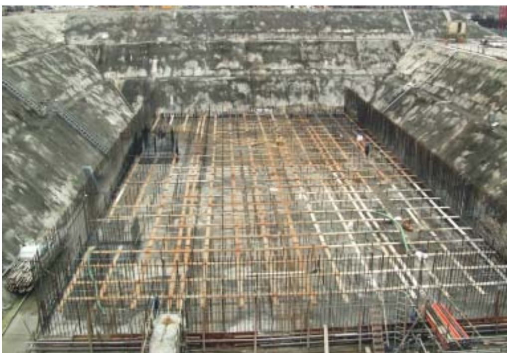
照片四：輔助用過燃料廠房施工現況
