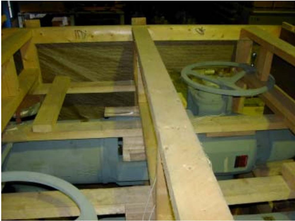
電動閥 1E22-MBV-004B 儲存現況
