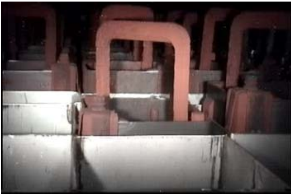
圖九 用過燃料束 KBF082 置於儲存格架
