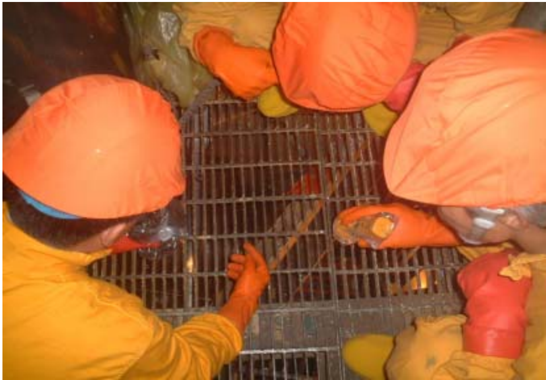
照片五 原能會視察員於現場視察再循環管路 AH-J1 焊道滲水狀況
