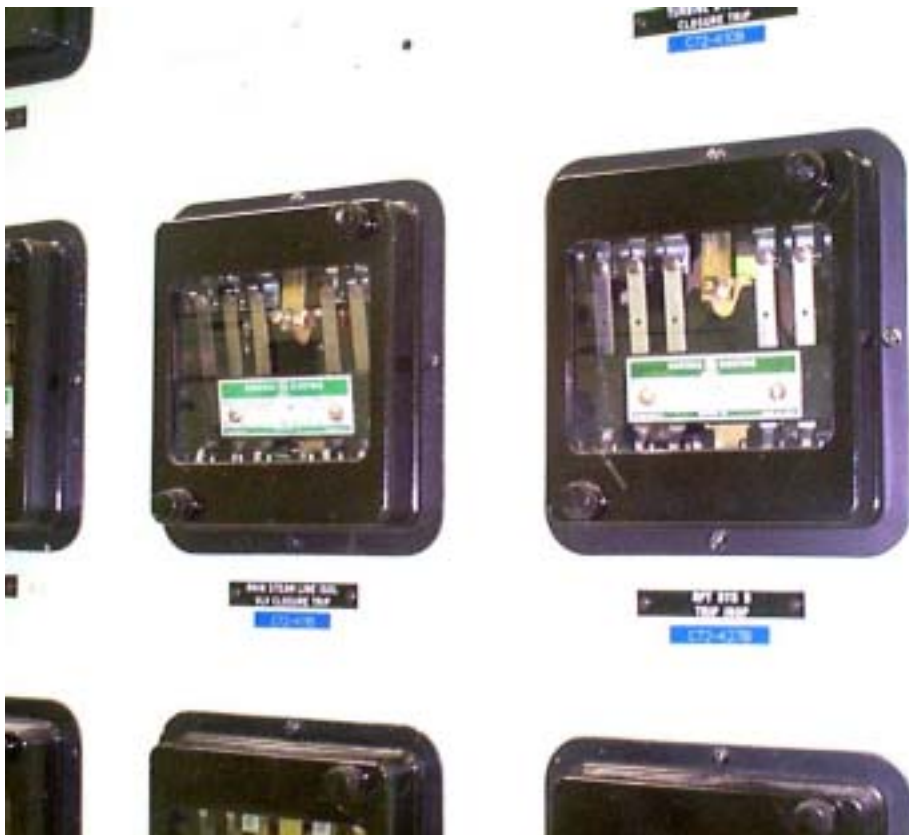
附圖三 核一廠位於主控制室 H11-P609 及 H11-P611 盤之 RPS 電驛
