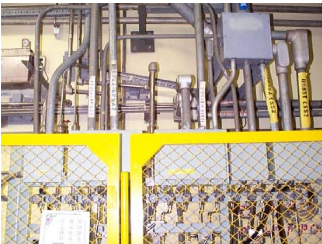
附圖四 核一廠反應爐保護系統現場儀控管線以圍籬保護情形
