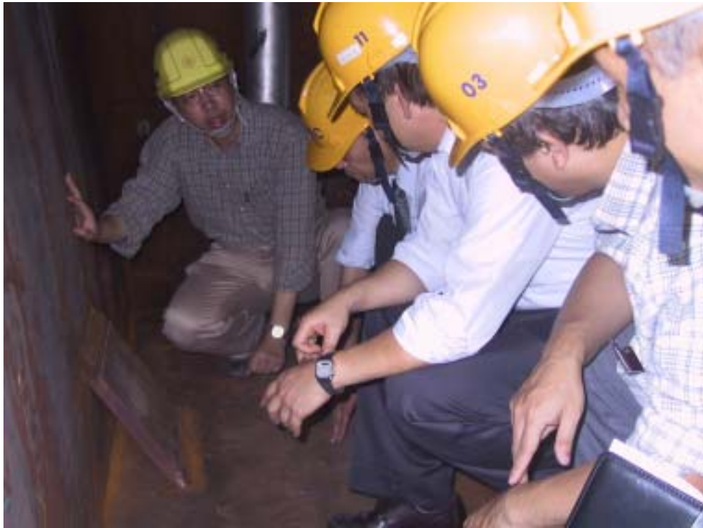
照片三：視察反應器基座第一層輔助板拆除作業情形
