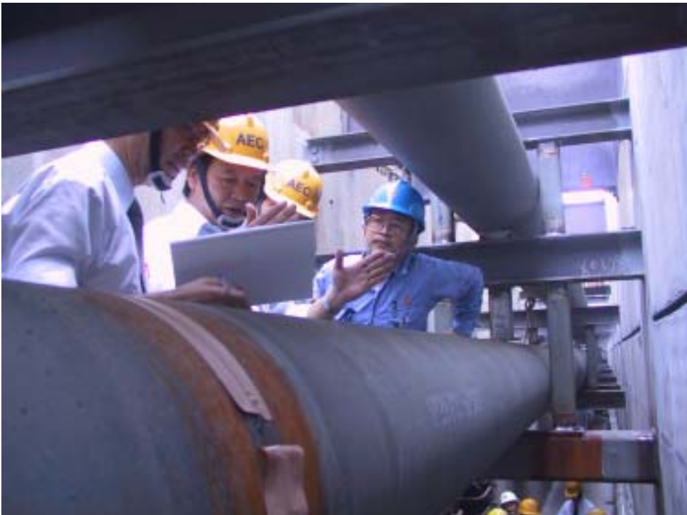
照片二：視察反應器廠房機械設備及管路安裝情形
