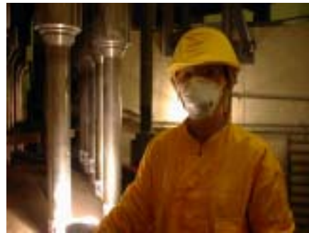
核三廠二號機大修控制棒驅動機構穿越管檢視
