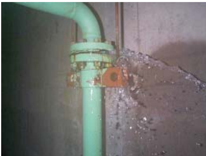
洩漏之情況 (系統已隔離, 所洩之水 為槽內原有之水)
