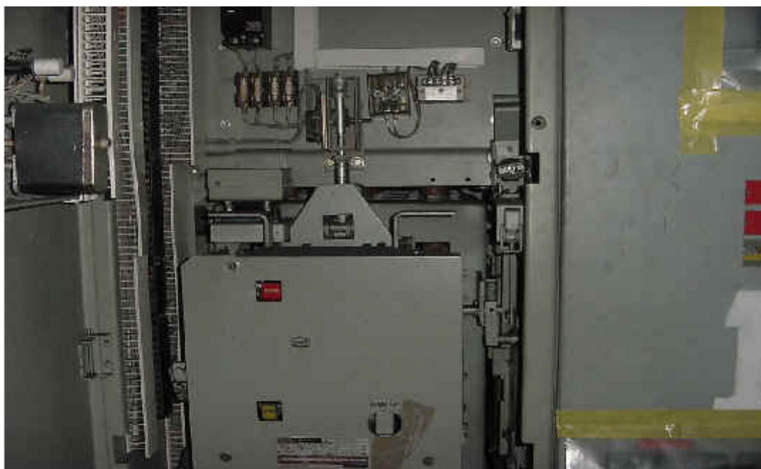
正常斷路器插入匯流排情形
