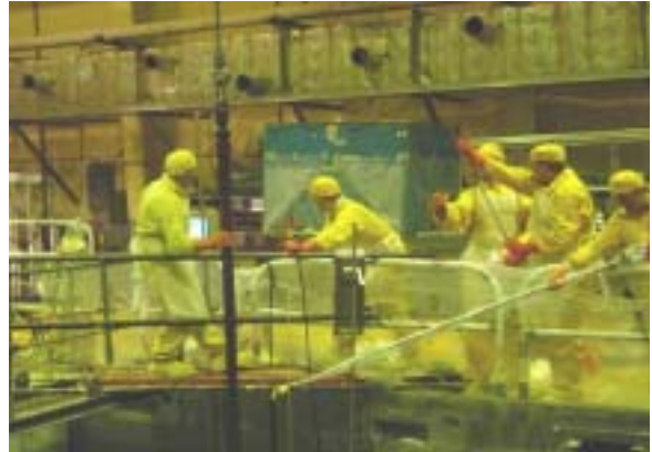
核子反應爐執行水下目視檢測
