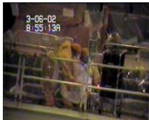
核一廠二號機大修控制棒葉片現場檢查情形
