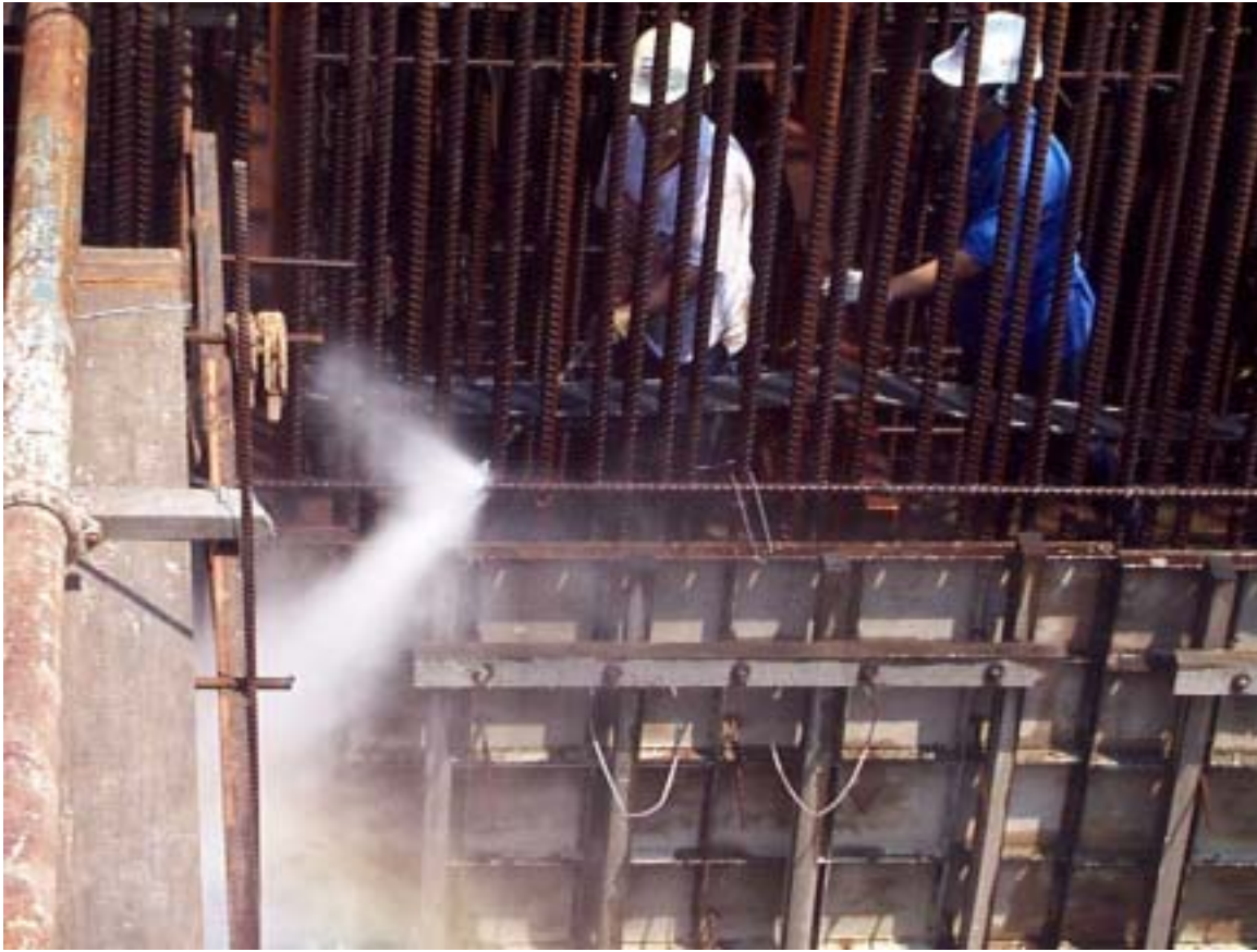
(圖七) 一號機汽機廠房基礎第三區塊之水刀除鏽現況景二
