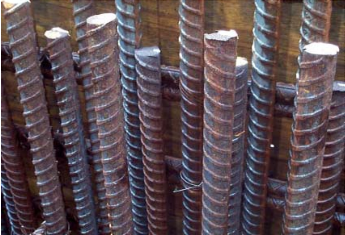
(圖九) 一號機汽機廠房基礎第三區塊之水刀除鏽鏽後現況
