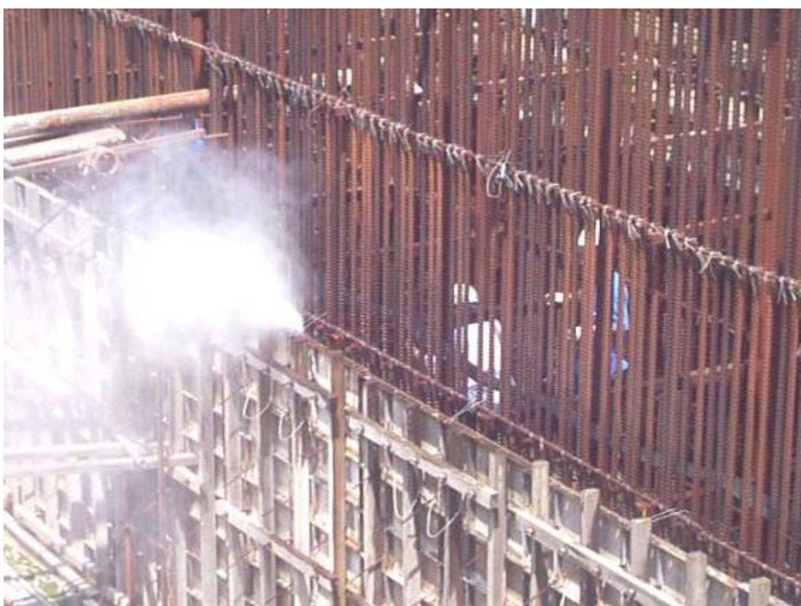
(圖六) 一號機汽機廠房基礎第三區塊之水刀除銹現況景一
