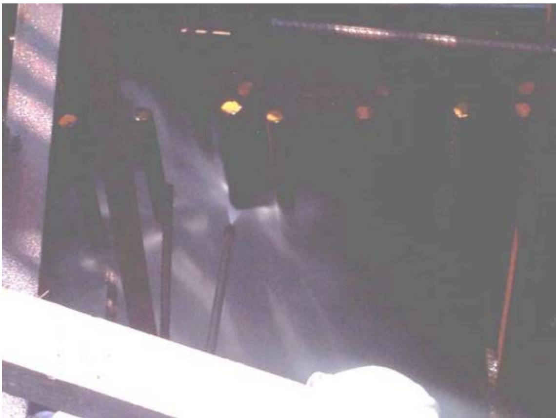
(圖八) 一號機汽機廠房基礎第三區塊之水刀除鏽現況景三
