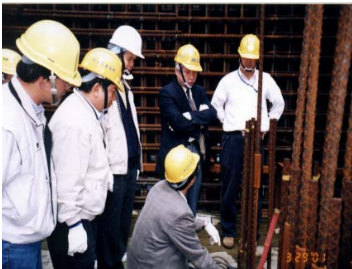
(圖四) 原能會會同專家學者赴反應器廠房現場實勘鋼筋鏽蝕情形
