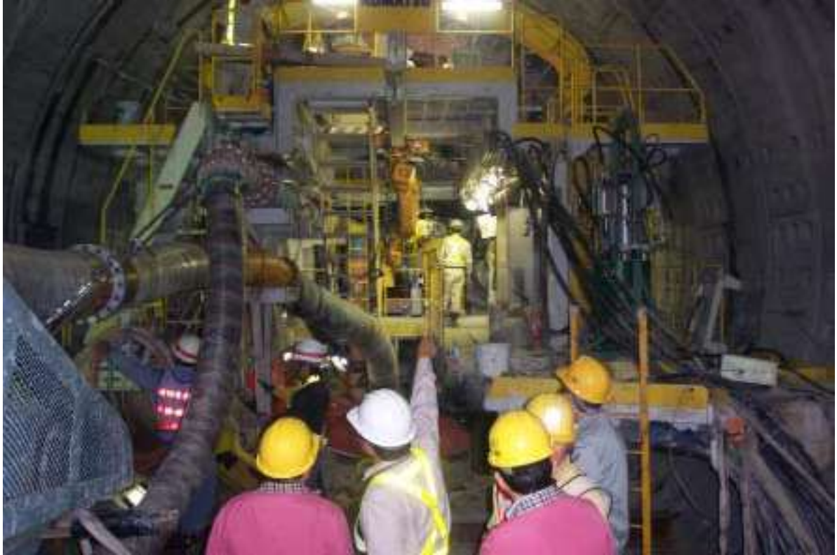
照片三：一號機循環水出水道工程潛盾作業執行情形
