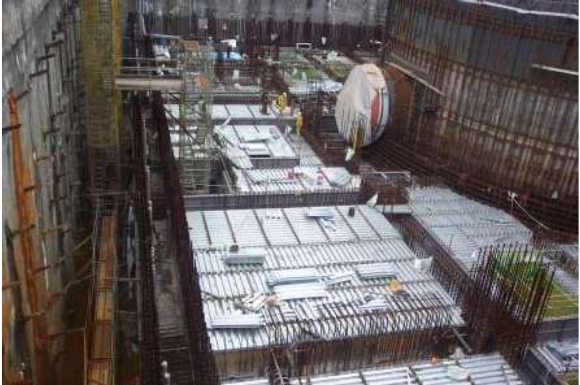
照片一：一號反應爐廠房西側 EL-1700mm 之樓版鋼樑組立情形
