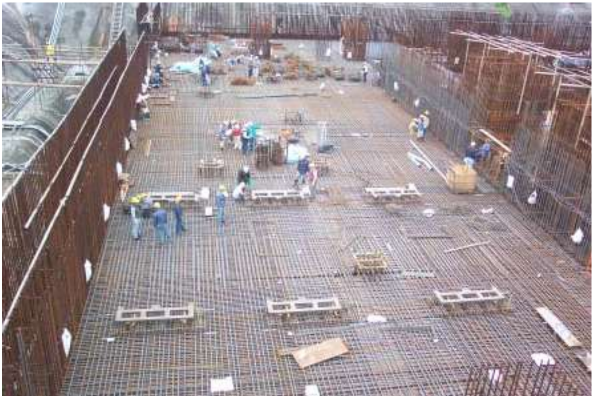
照片二：一號機汽機廠房基礎第十五區塊施工現況
