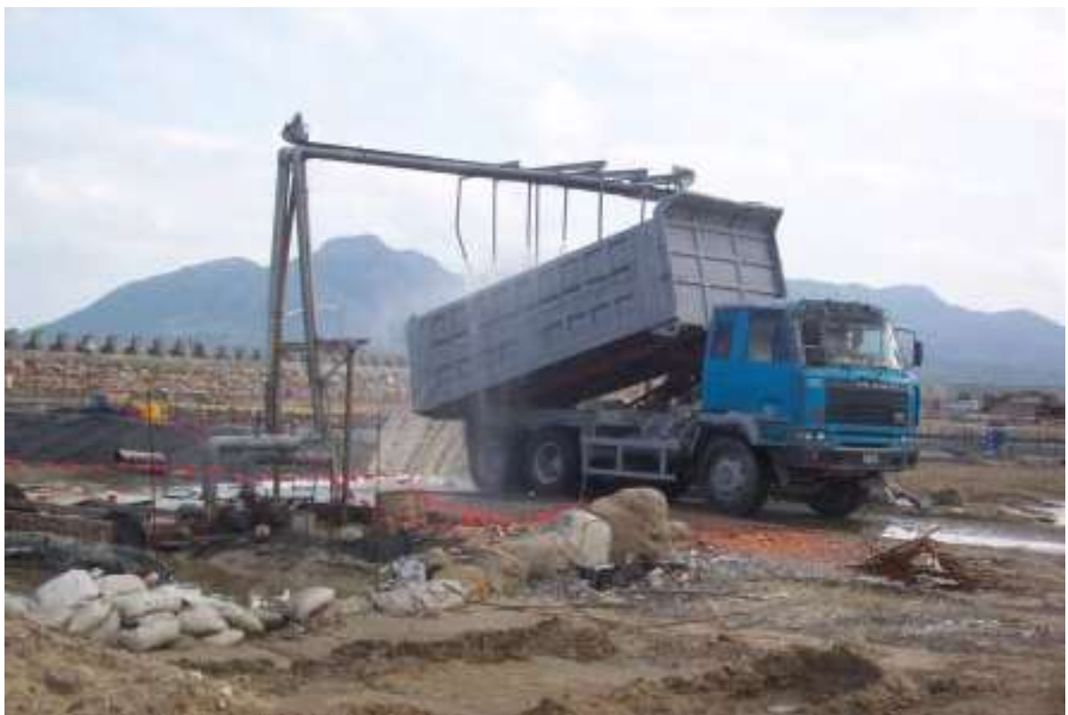
照片四：重件碼頭拋石作業前石塊清洗執行情形
