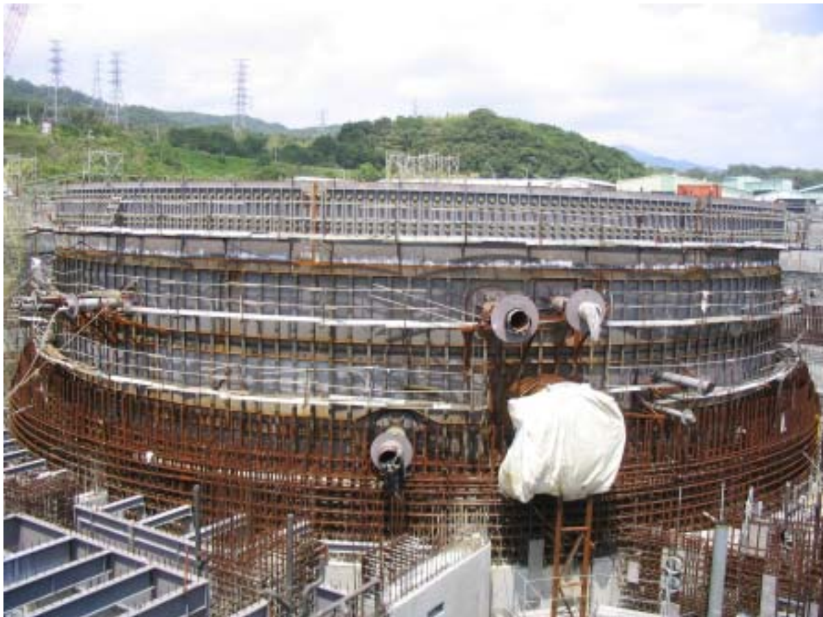
照片四：二號機反應器廠房施工現況圖景
