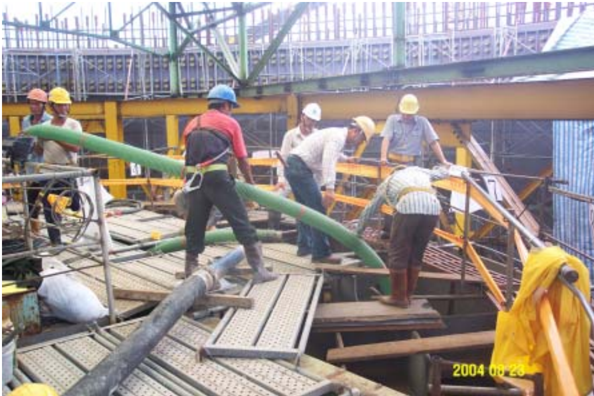
照片三：一號機反應爐基座第一階段混凝土澆置作業現況圖景
