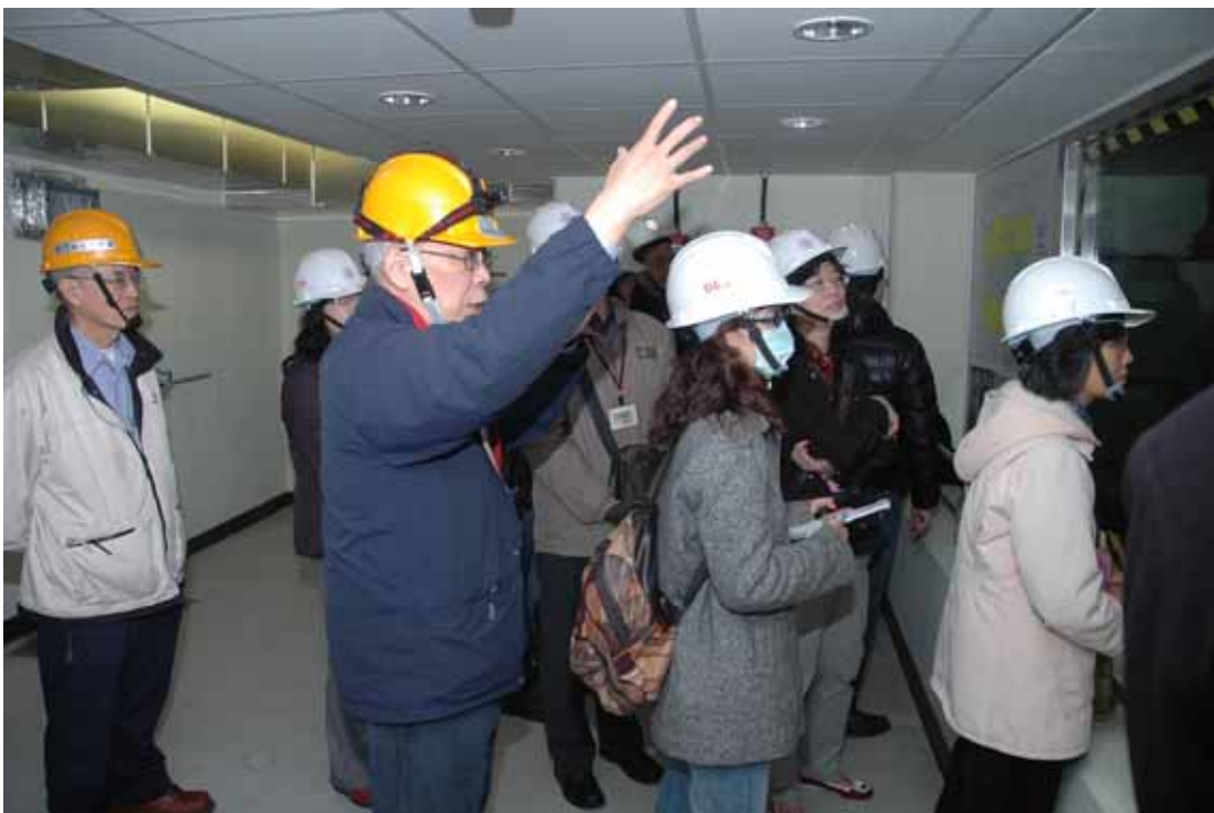
圖 2 核能四廠安全監督委員巡查一號機反應器廠房及汽機廠房 施工現況
